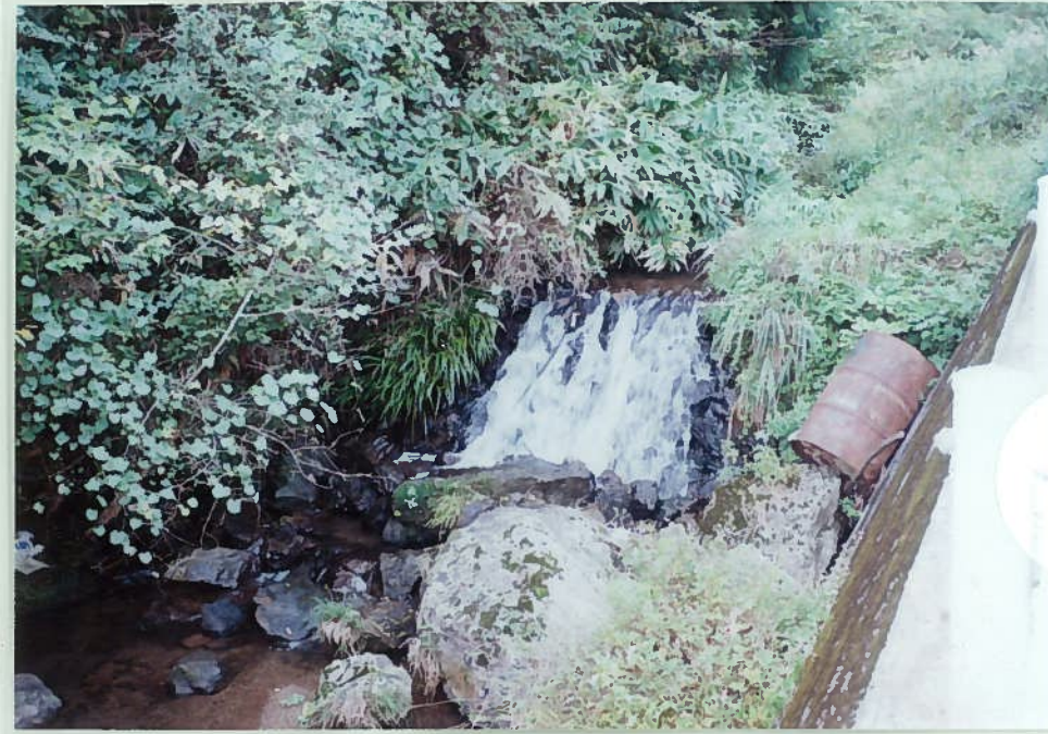
89)井田川 25. 頭首工 h=2m 石積工である。
