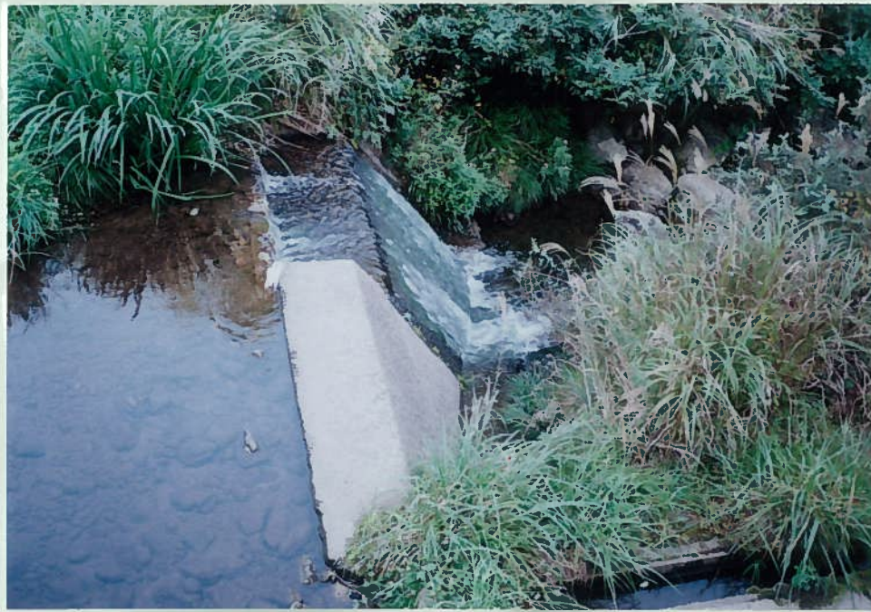
89)井田川 22. 頭首工 h=1.5m 石には泥が付着して いる。
