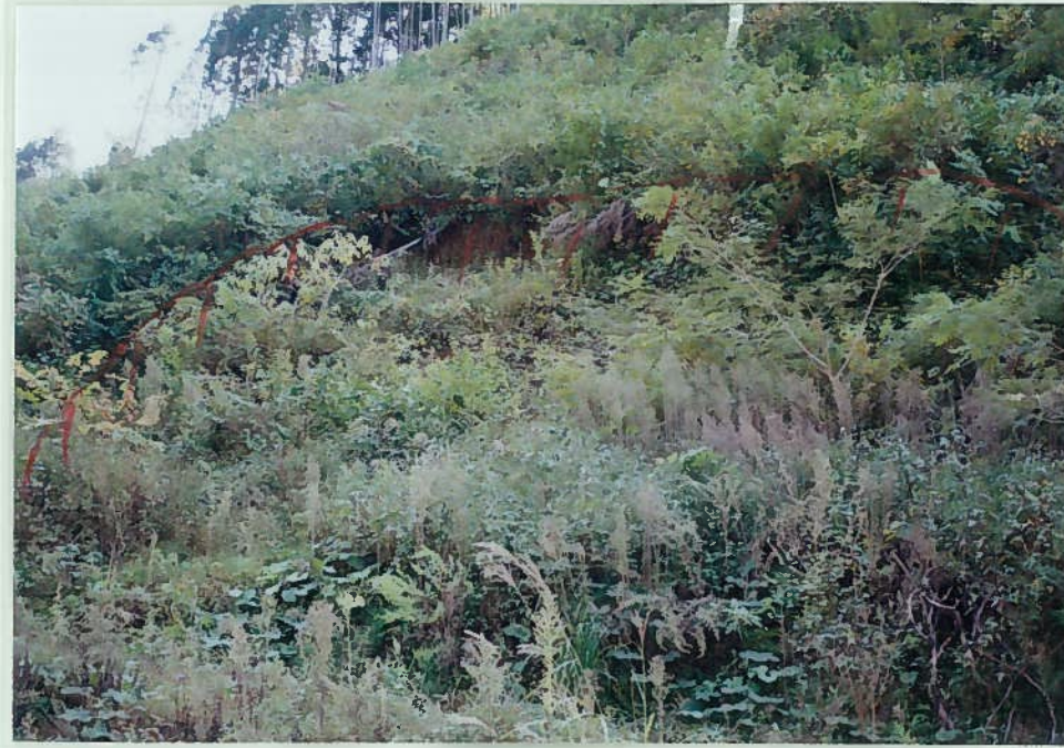
87)仮)長谷 13. 植林地の崩壊跡
