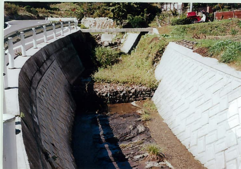
87)仮)長谷 14. 床留工 h=1m ふとん籠で施工
