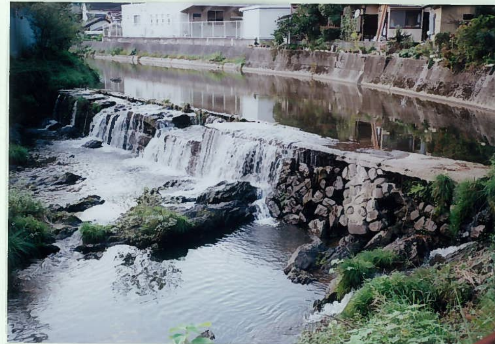
86)月田川 2. 頭首工 h=1.5m 石積頭首工で魚の住 処ともなっている。 おもいよう。
