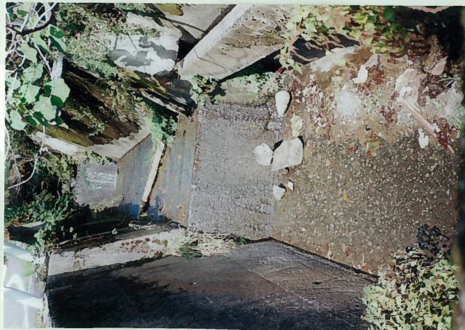
86)月田川 30. 床留工 h=1m×2段 三面張で魚の遡上は 困難である。
