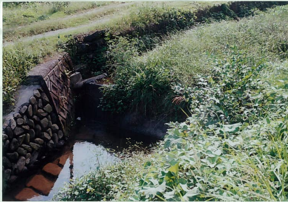
85)岩井谷川 19. 頭首工 h=1m 農地整備により河川 改修している。
