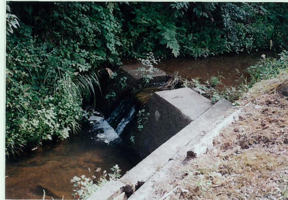
85)岩井谷川 29. 頭首工 h=1m ハヤがいるのみ。
