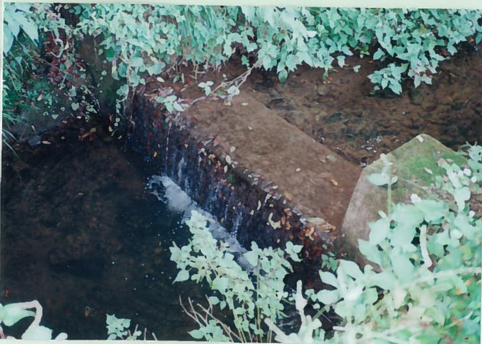
85)岩井谷川 27. 頭首工 h=1m ハヤがいるのみ
