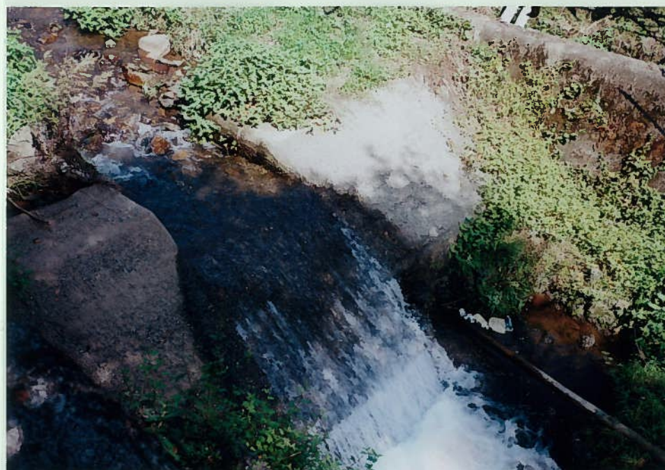
84)後谷川 20. 頭首工 h=2m
