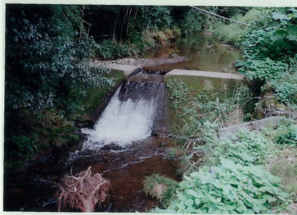
84)後谷川 15. 頭首工 h=1.5m
