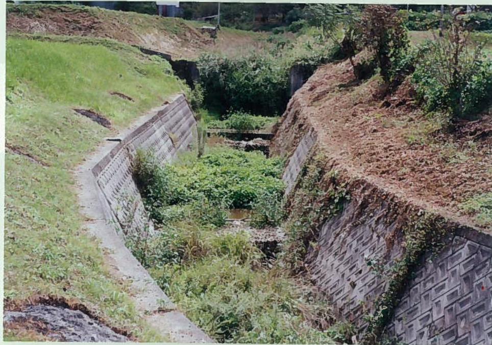
83)和田川 22. 床留工 h=0.5m ブロック積み護岸と床留工で固められており、魚はいない。
