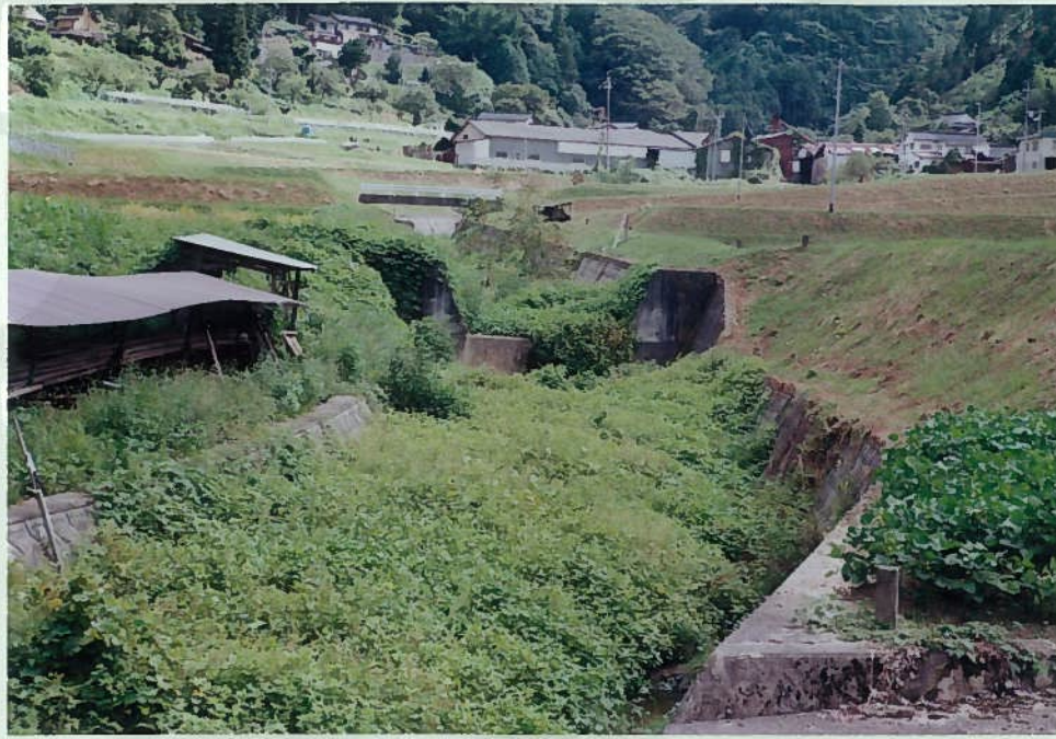
83)和田川 21. 床留工 h=1m 川には草が茂っている。
