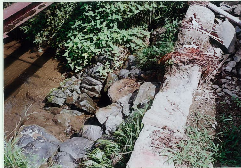
83)和田川 24. 頭首工 h=1m 自然石を積み上げており、魚にやさしい構造である。
