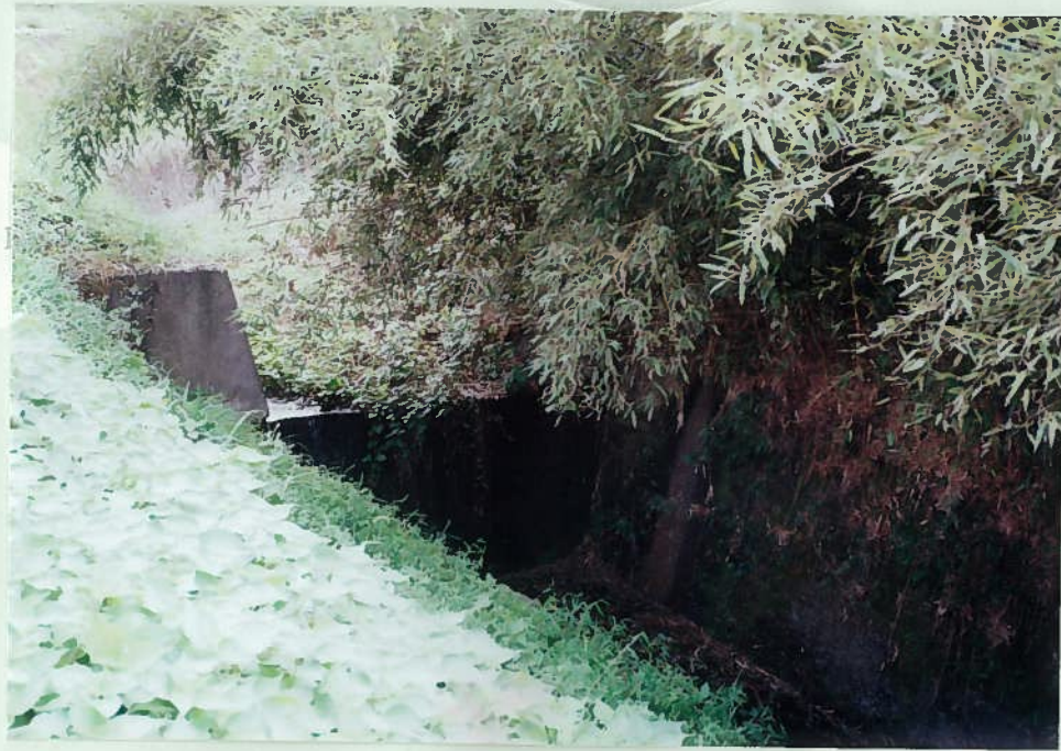
83)飯)手谷川 15. 床留工 h=1.5m 魚の遡上は困難である。
