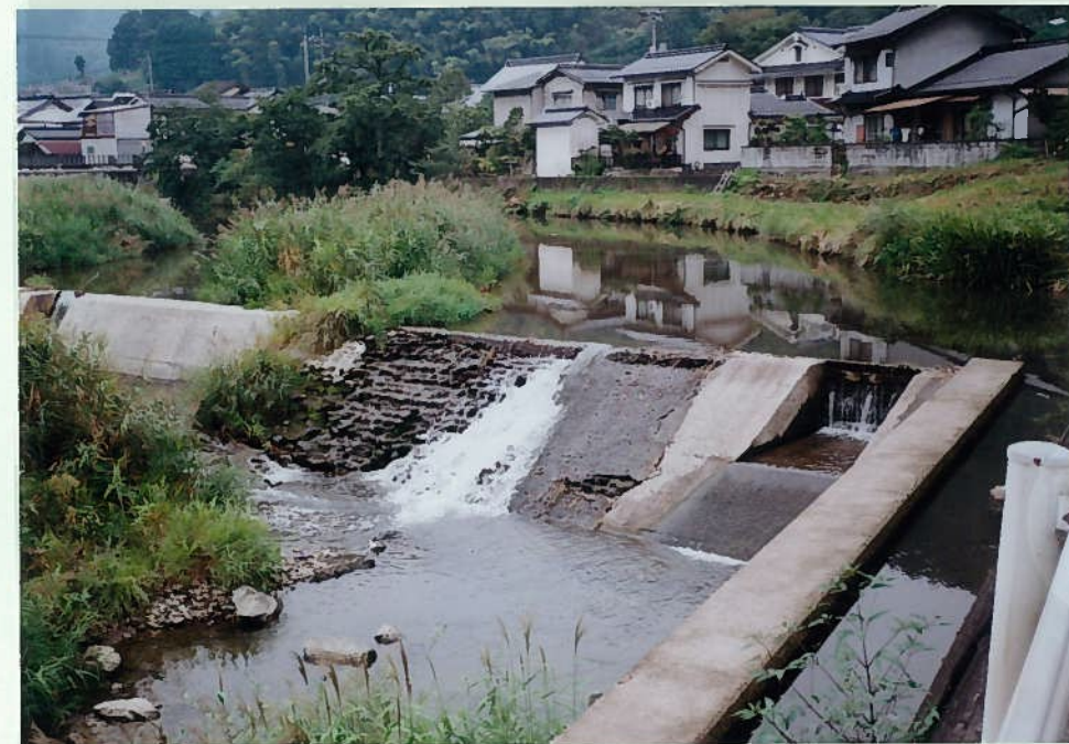
82)月田川 8. 頭首工 h=2m 緩傾斜で石張として いる。
