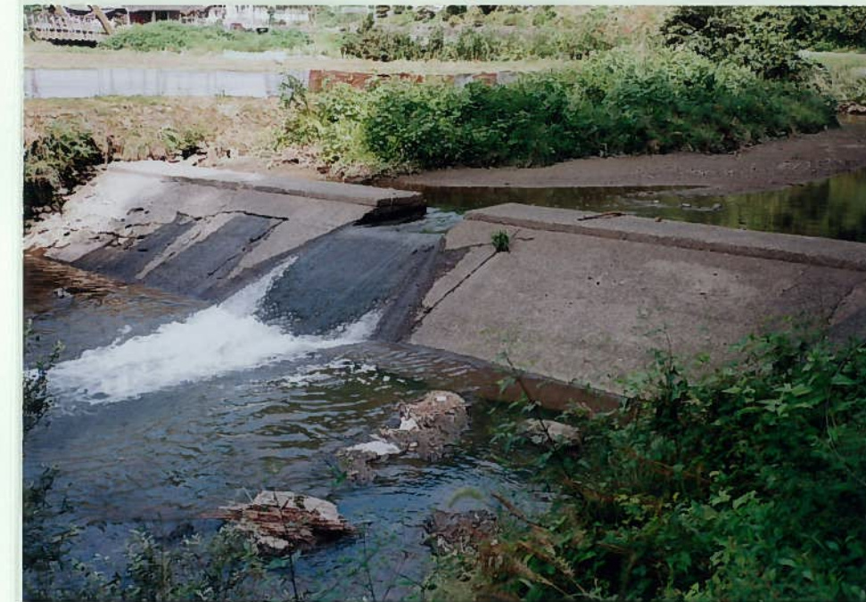
82)月田川 20. 頭首工 h=1.5m 魚にやさしい構造で ある。
