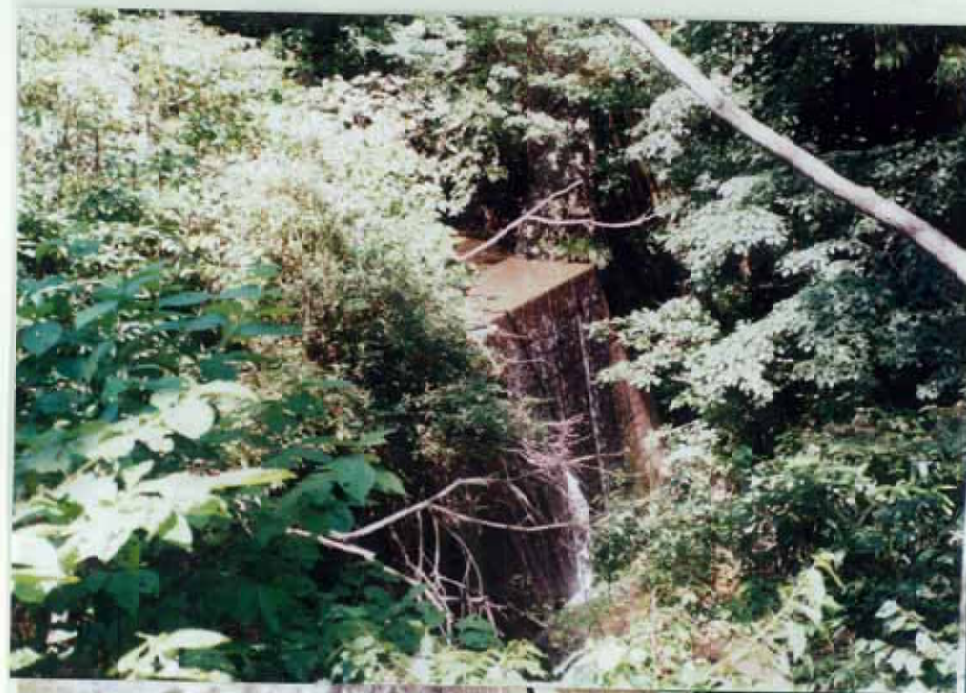
80)野土路川 42. 砂防ダム h=7m
