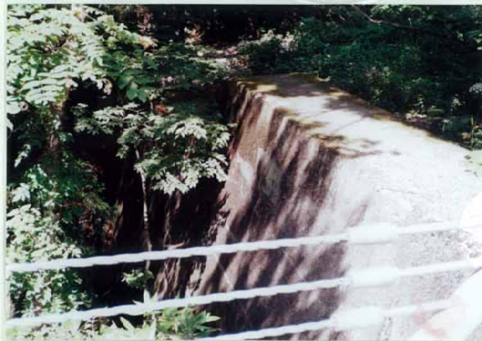
80)野土路川 40. 砂防ダム h=10m
