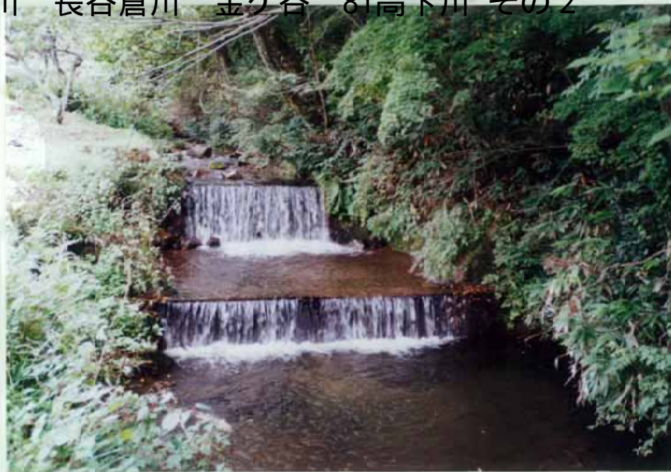
81)高下川 19. 床留工 h=1m+2m 魚の遡上はやや困難 である。
