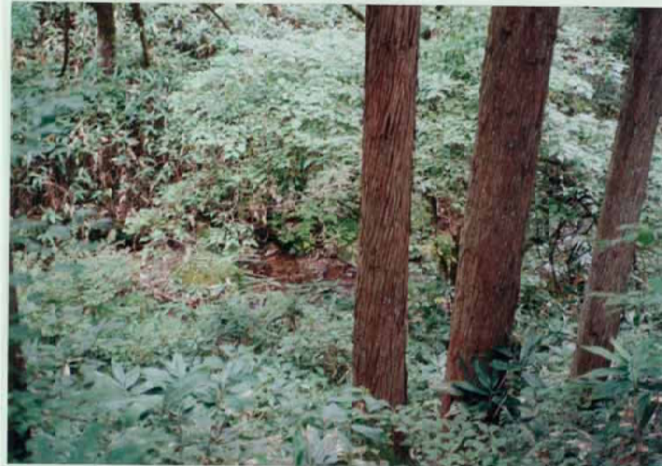
81)高下川 23. 自然流である。 流域は全て植林地で 土砂の流出が多くな り、漏水しやすくなっ たとのこと。
