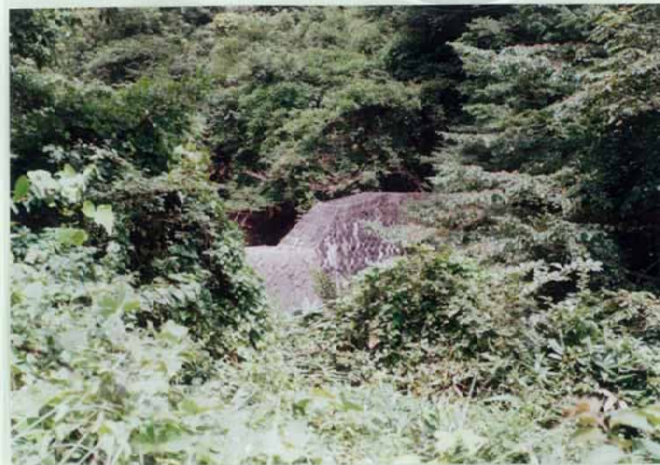
81)高下川 22. 砂防ダム h=10m 上下を分断している。
