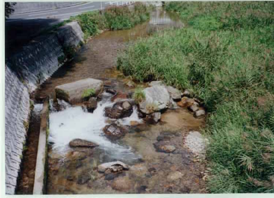
80)野土路川 12. 取水工 石を積んでおり魚にやさしい構造である。ジャコ・ヒラメ・シマドジョウ等が泳いでいる。
