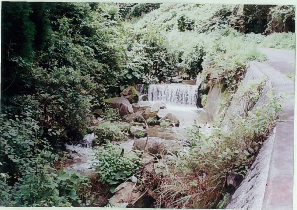
78)戸島川 15. 頭首工 h=1.5m 川は自然に近い姿で ある。
