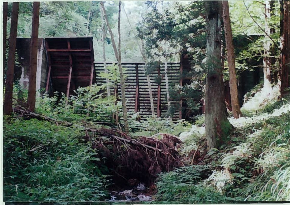
78)野呂川 28. 透過式砂防ダム h=5m 魚の移動は可能である。
