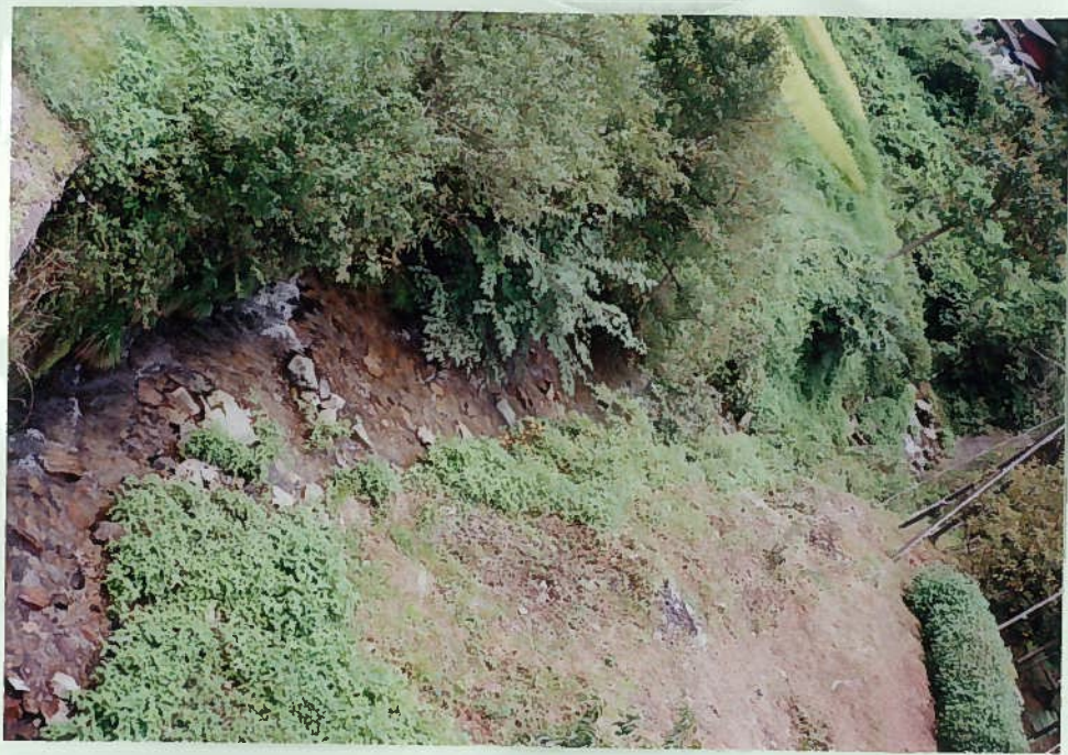
78)戸島川 13. 砂礫の堆積する自然 状態の川である。
