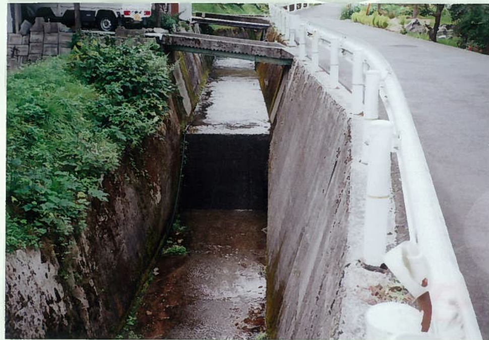
76)大所 16. 三面張+段差工 h=1.5m 魚はいない。
