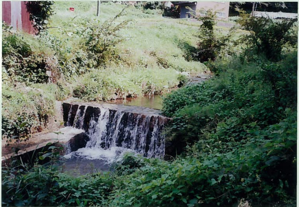
76)山路川 14. 床留工 h=2m 魚の遡上は困難である。
