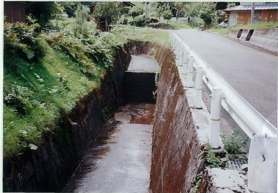
76)大所 17. 三面張+段差工 魚はいない。
