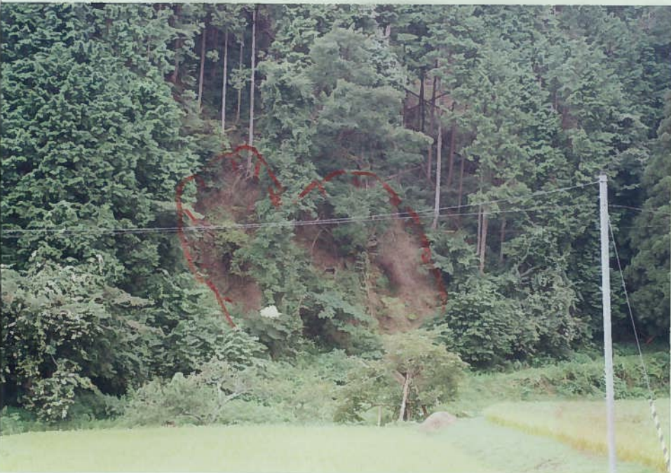
75)平島川 23. 斜面崩壊跡 植林地が崩壊している。
