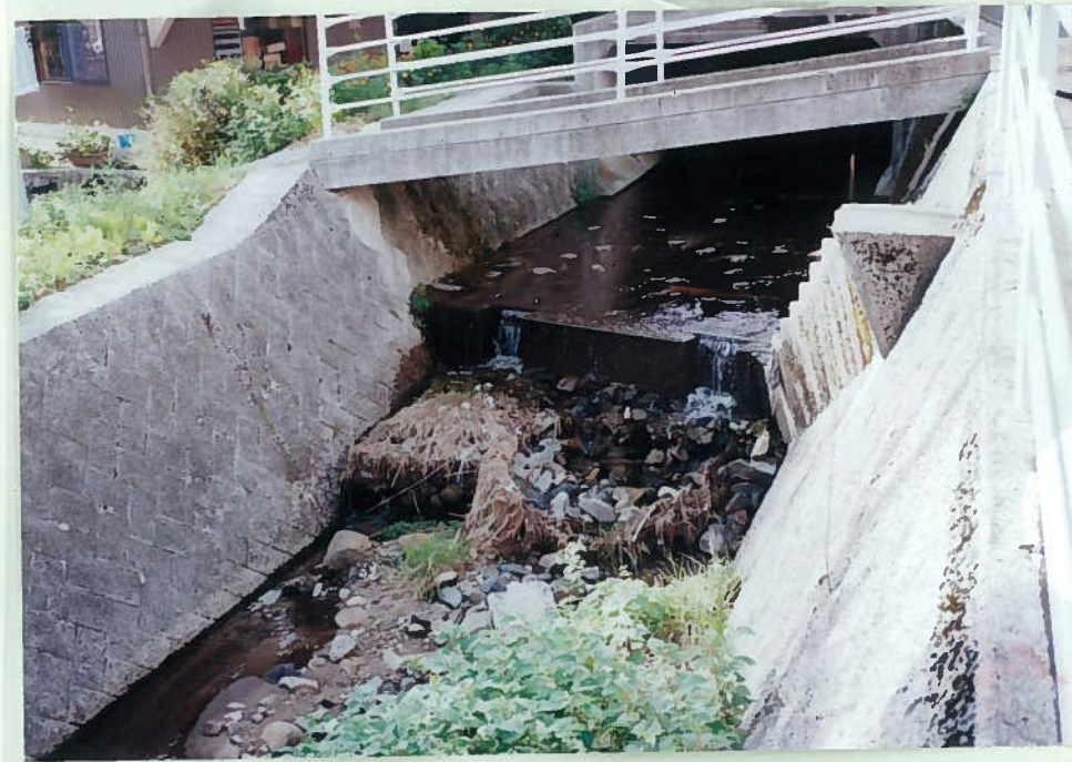
75)森谷川 1. 三面張り段差工 水も少なく魚はいない。
