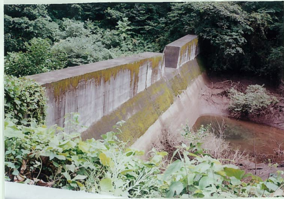
75)河田川 19. 砂防ダム h=10m 上下を分断している。
