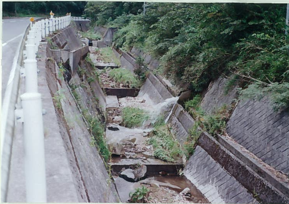
75)森谷川 4. ブロック積護岸と 段差工 水は少なく魚はいな い。
