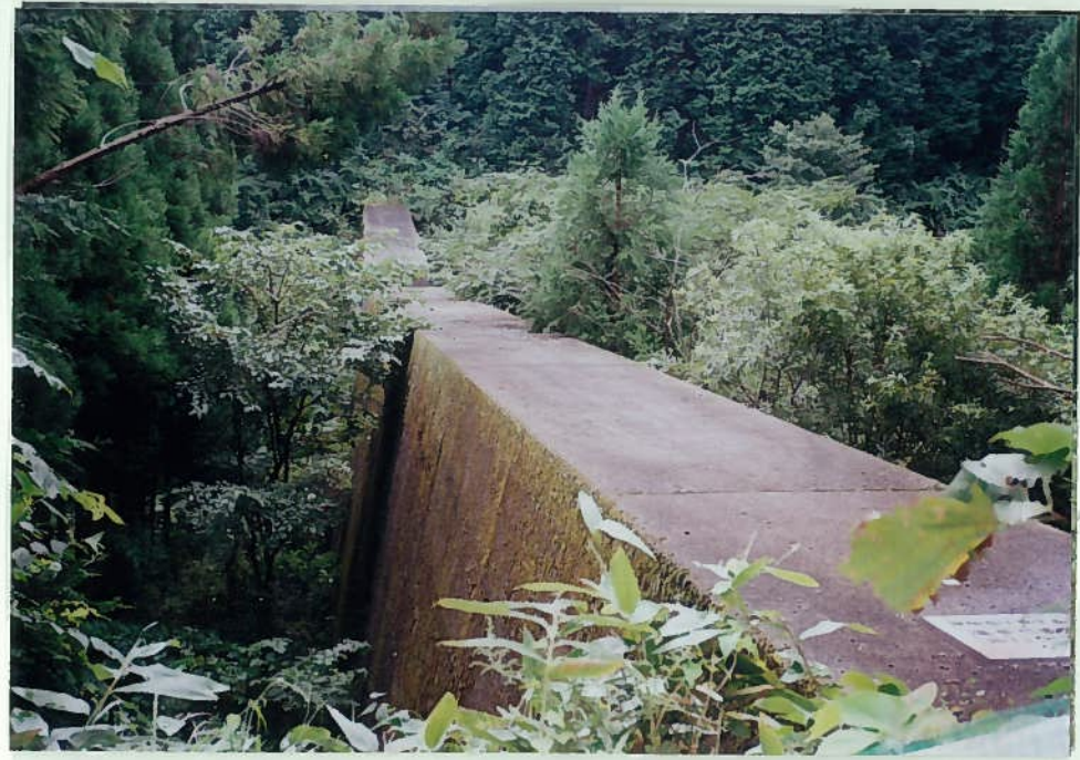
75)平島川 26. 砂防ダム h=11m S61年竣工 上下流を分断し魚はいない。
