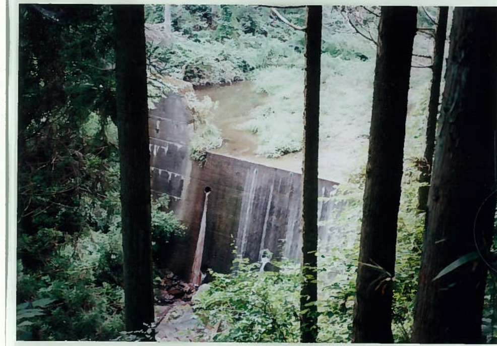
70)高山川 8. 砂防ダム h=7m 魚の移動は不可能である。
