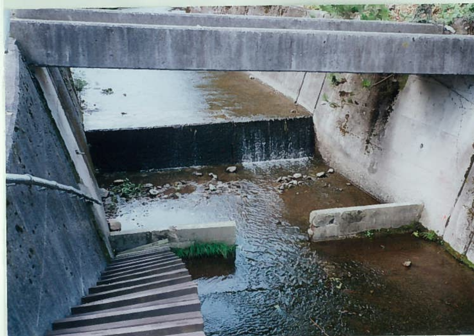
67)谷山川 2. 三面張工と段差工 魚はいない。
