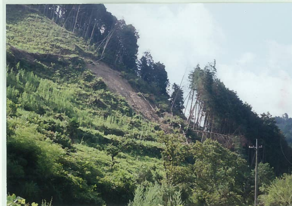
67)谷山川 3. 倒木地の崩壊跡 倒木は除去している。
