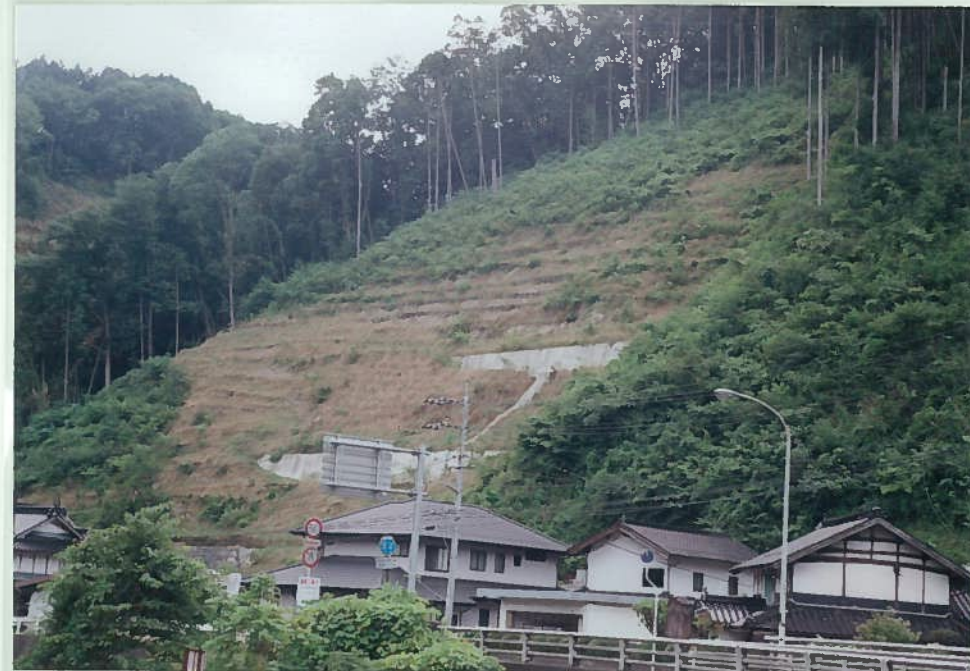
66)新庄川 8. 風倒木の崩壊跡 擁壁+のり面植生工 で復旧している。
