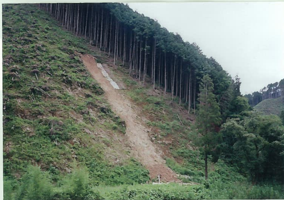
66)新庄川 6. 風倒木の崩壊跡
