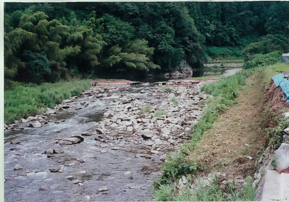
66)新庄川 7. 旧頭首工は崩れ、 砂礫川の流れとなっ ている。
