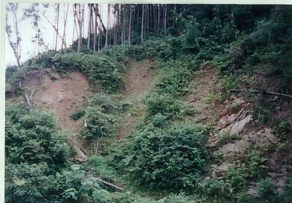
66)新庄川 9. 崩壊跡
