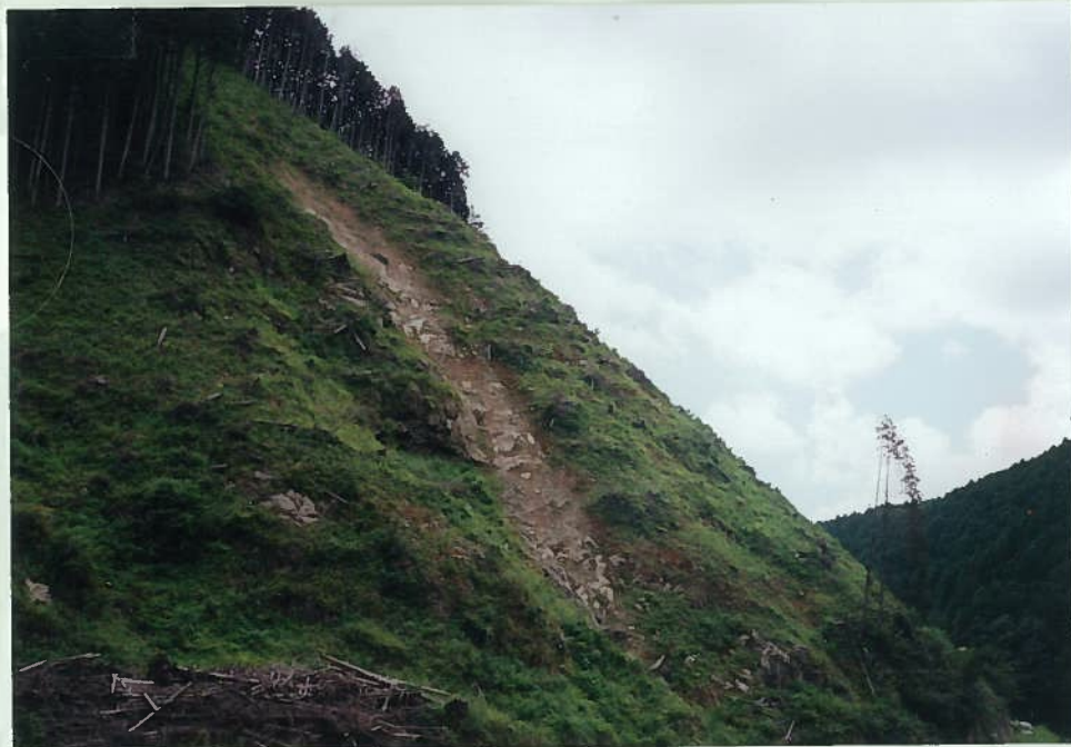
66)新庄川 5. 風倒木の崩壊跡
