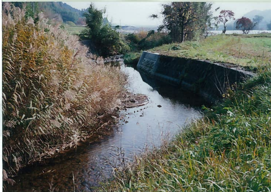
63)内海谷川 13. 河川状況 護岸と自然状態が半 半の川で、自然に近い 流れである。
