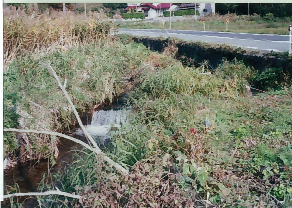
63)内海谷川 14. 頭首工 h = 0.5 m 右岸は自然堤でヨシ が茂る。 ヒラメが多数泳いで いる。
