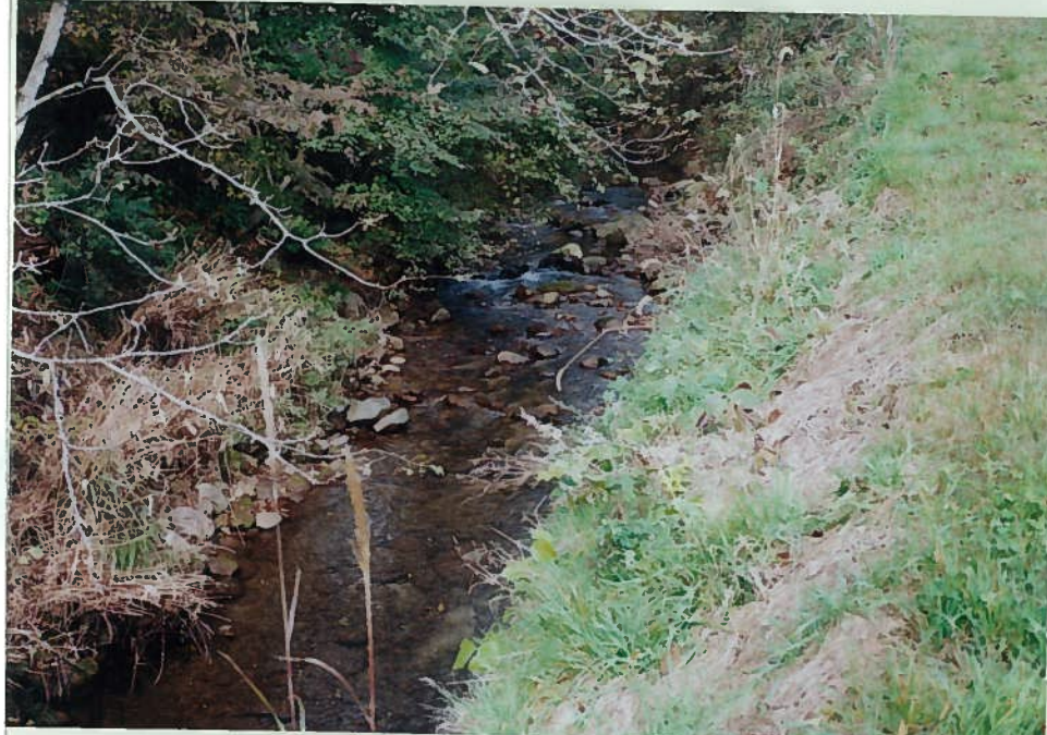
60)苗代川 2. 河川状況 護岸はあるが、片側 は自然に近い流れで ある。
