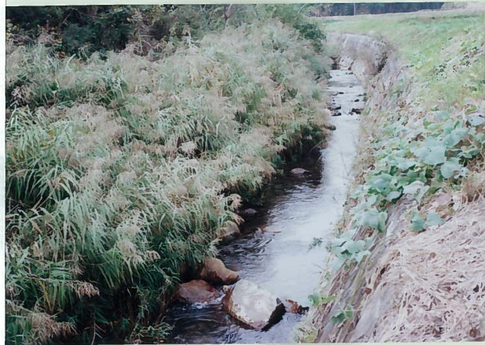
60)苗代川 8. 農地側は護岸工、山側は自然状態である。流れは自然にちかく大山椒魚の生息も期待されるが魚は少なそうである。
