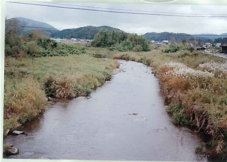
59)明連川 15. 河川状況 幅広い河原はヨシが 茂り、川には魚が多く 泳いでいる。
