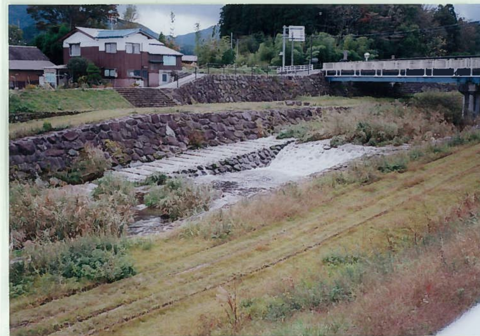
59)明連川 17. 頭首工 礫を積み上げており 魚にやさしい構造で ある。
