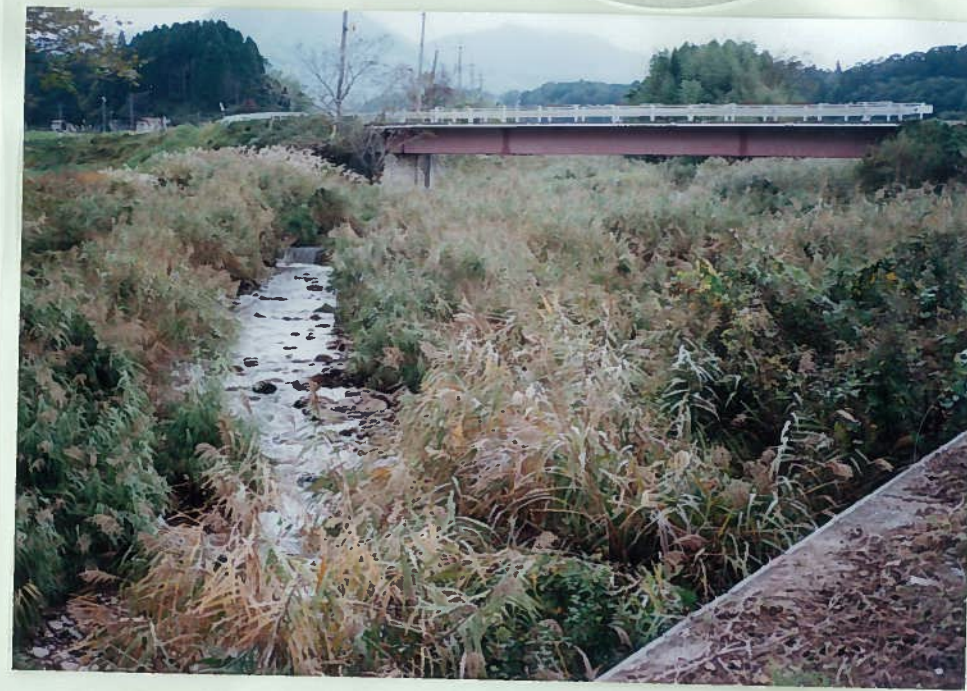
59)明連川 21. 頭首工 h = 1\text{ m} 川はヨシが茂り、自 然に近い流れである。
