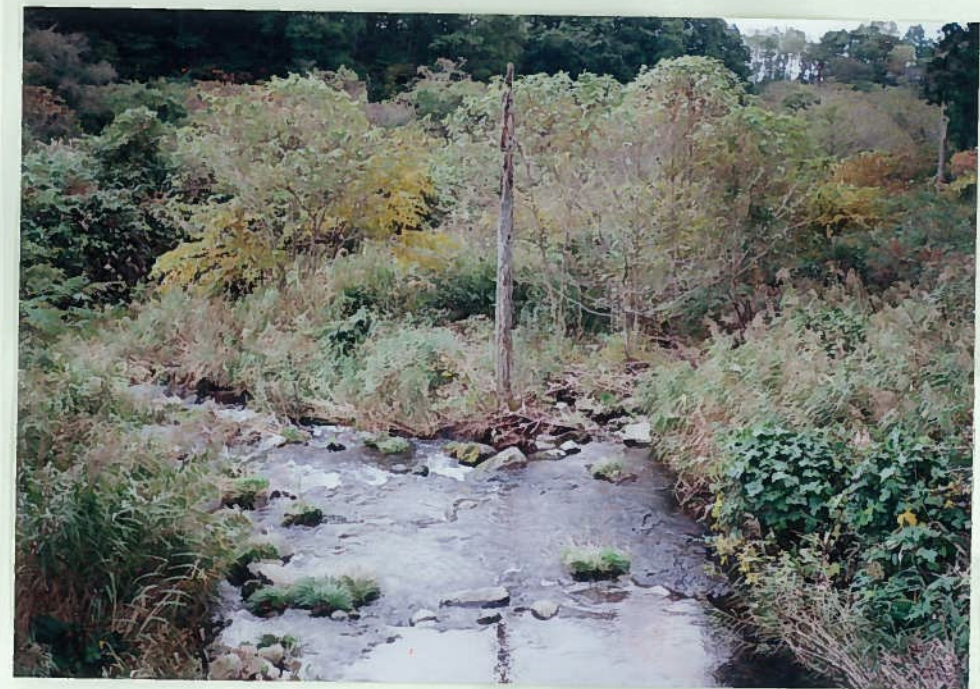
59)明連川 23. 河川状況 護岸は無く自然状態 の流れである。
