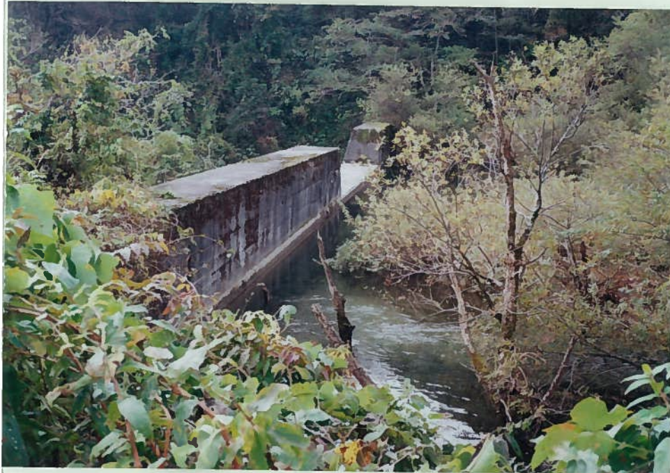
59)明連川 25. 砂防ダム h = 8 m 魚の移動は不可能で ある。
