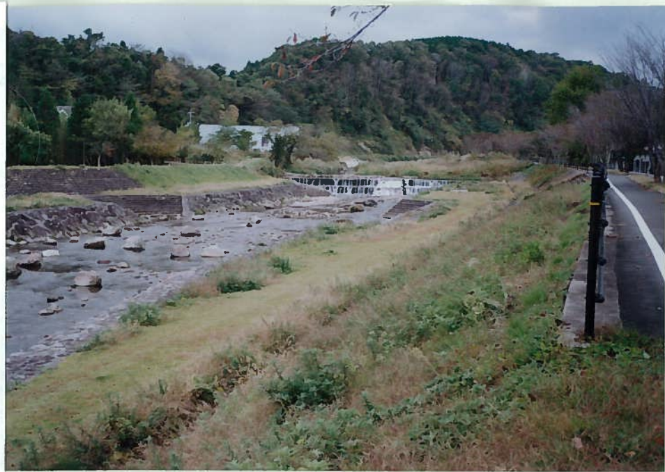
59)明連川 18. 河川状況 河川公園として整備 し、石積頭首工は魚 にやさしい構造であ る。
