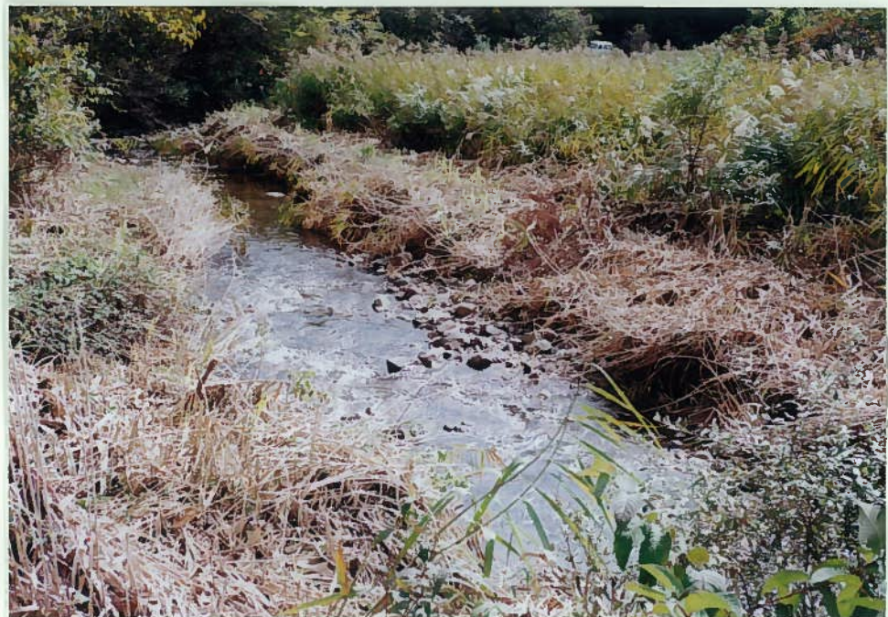
58)湯船川 12. 河川状況 礫川で自然の流れで ある。
