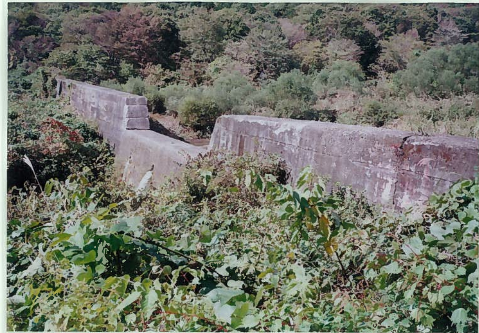
58)湯船川 10. 砂防ダム h = 8\text{ m} 上流側は広く堆砂し ている。
