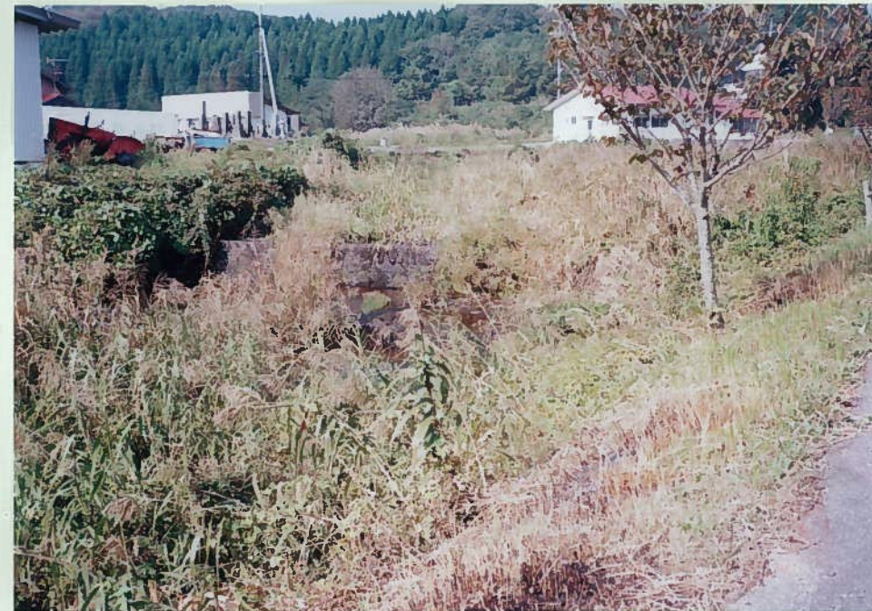
54)三谷川 2. 頭首工 h = 1.5 m 左の施設から産業排 水が流出し、魚はいな い。
