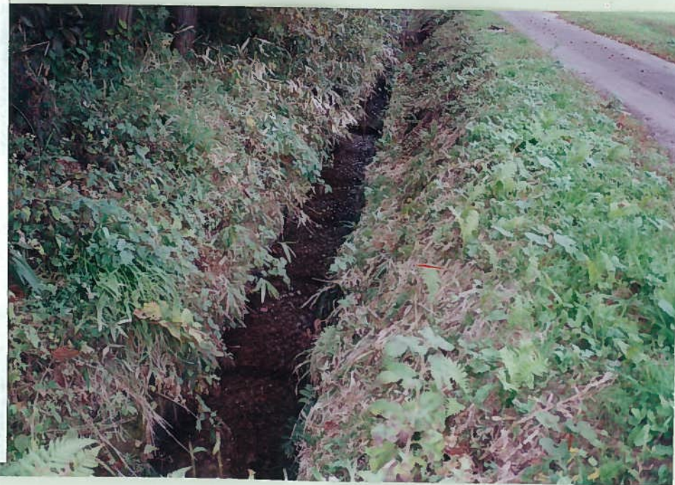
55)井川 12. 三面張工 川床は止め工として いる。魚はいない。
