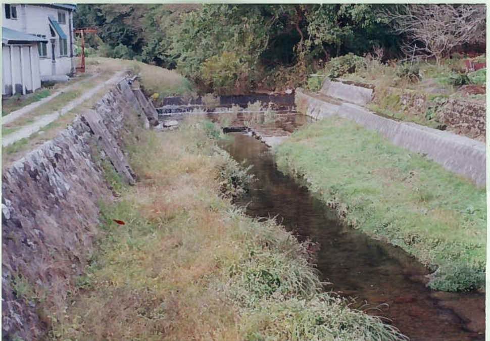
56)中谷川 25. 頭首工 h = 1\text{ m} 清流であるが魚影は うすい。
