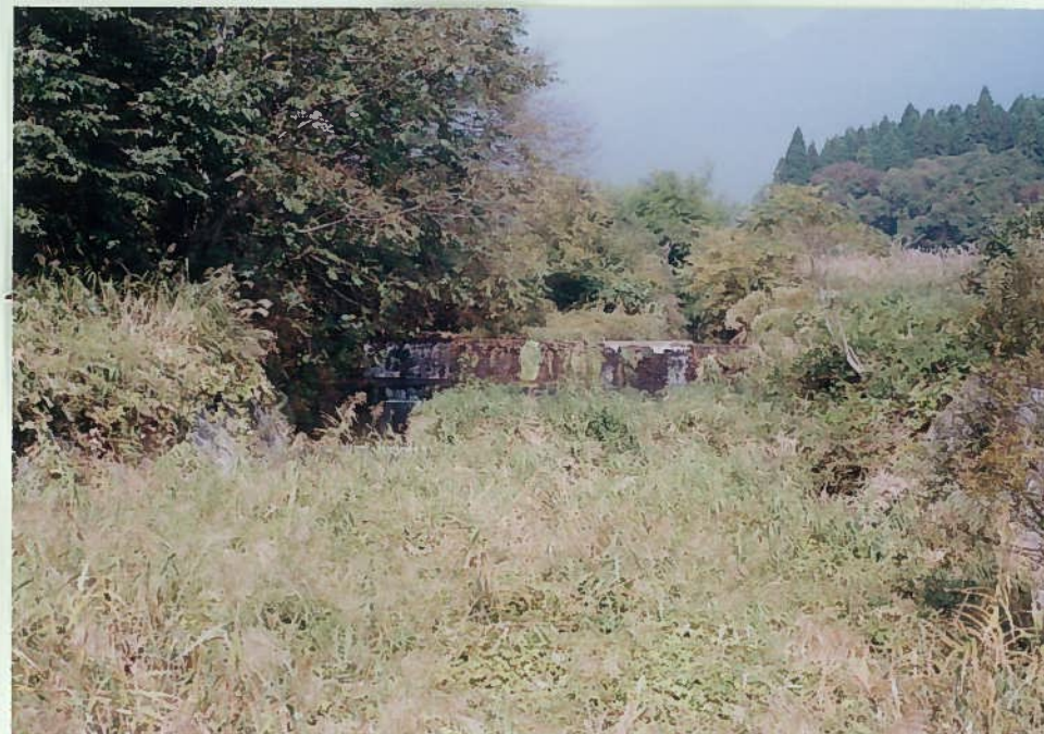
54)三谷川 3. 頭首工 h = 2 m 三段の構造となっ ており、魚の遡上は難 かしい。 魚も見られない。
