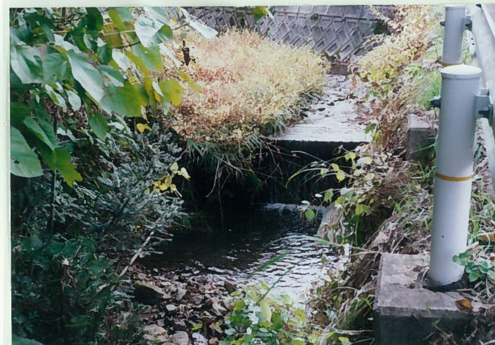
50)旭川源流 35. 床止め工 h = 1 m
