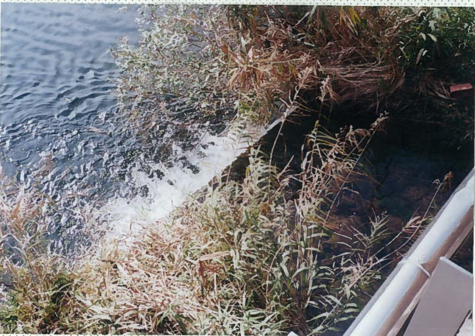
49)三谷川入口 9. 床止工 h = 1.5 m 旭川合流点 魚の遡上はやや困難 である。
