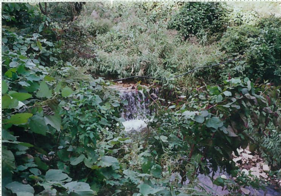
48)深谷川 26. 床止工 h = 2.5 m 魚の遡上は難しい。
