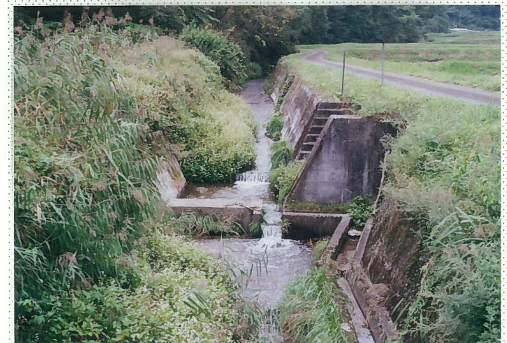
47)山田川 9. 頭首工。h = 0.5m 川はコンクリート三面張で魚は住めない。
