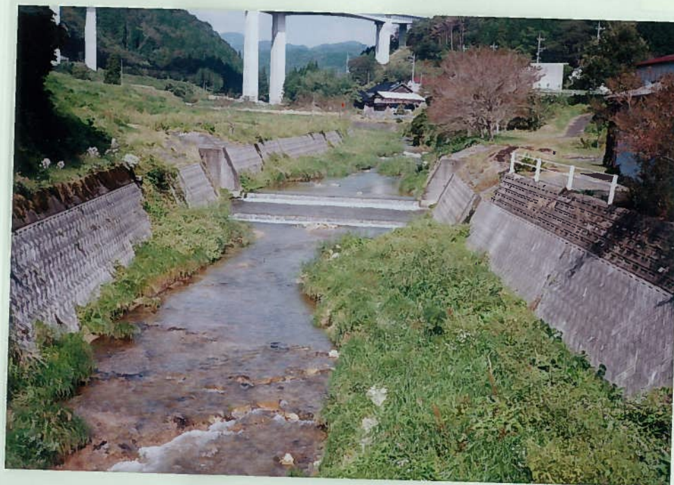
44)栗谷川 13. h = 0.5\text{m} \times 2\text{段} 。 護岸は整備されてい る。
