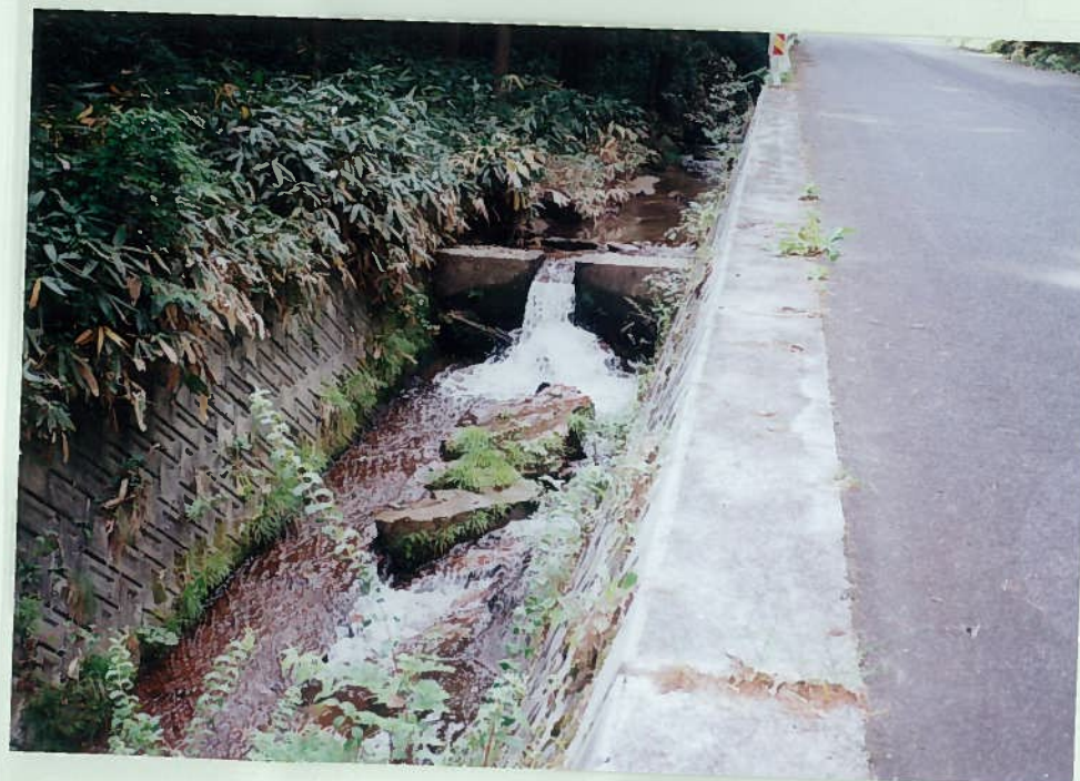
46)柳谷川 14. h = 1.0\text{m} 。床固め 工があり、魚の遡上 用いて難儀である。
