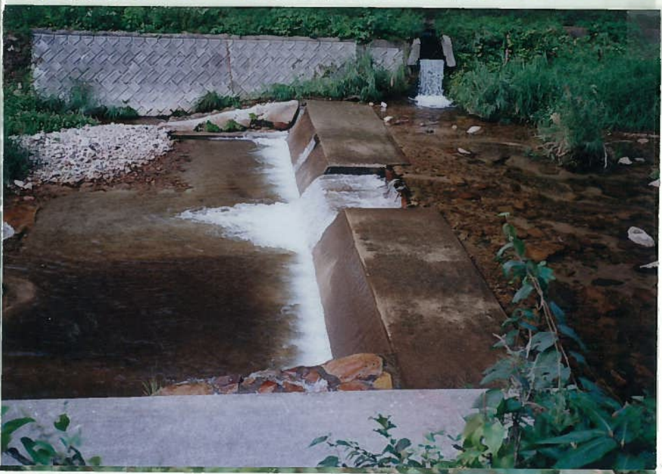
44)栗谷川 11. h = 1.5\text{m} 。手前に 石積のスロープがあ り、山椒魚でものぼ れる。
