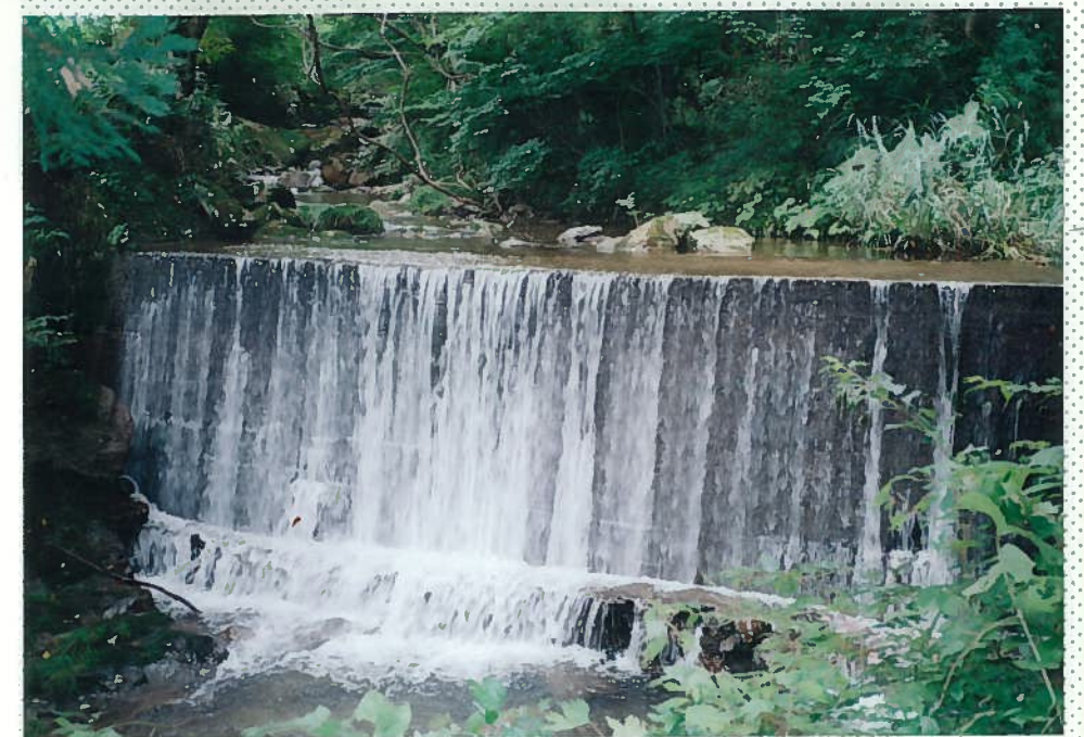
39)田羽根川 6. 砂防堤。h = 3 m。 魚の遡上は不可能である。
