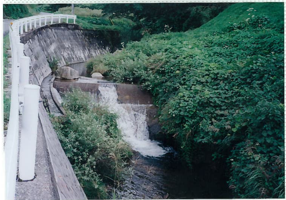
40)白根川 13. 頭首工。h = 3 m。 魚の遡上は不可能で ある。
