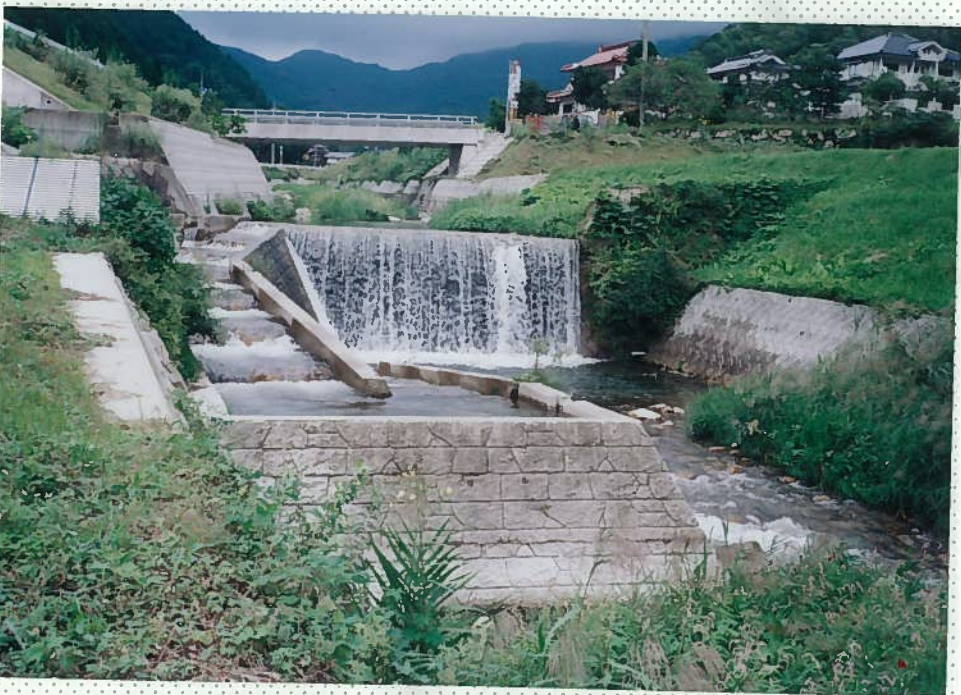
39)田羽根川 5. 床止堤。h = 5 m。 魚道がある。
