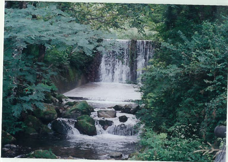
40)白根川 16. 砂防ダム。h = 5 m 魚の移動は不可能である。
