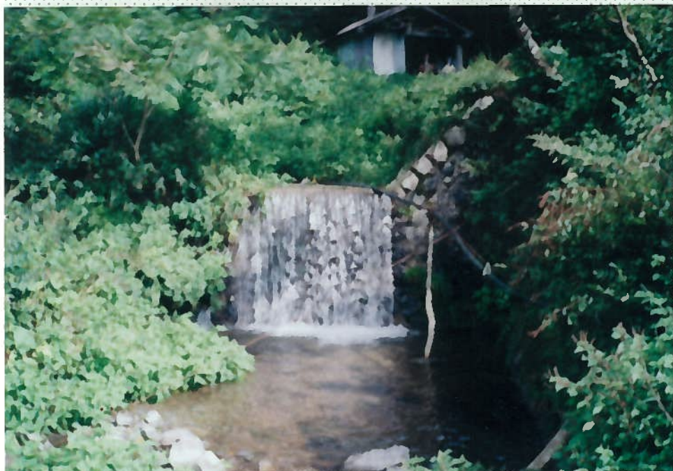
39)田羽根川 25. 砂防ダム。 h = 2.0 m。 魚の遡上は困難であ る。
