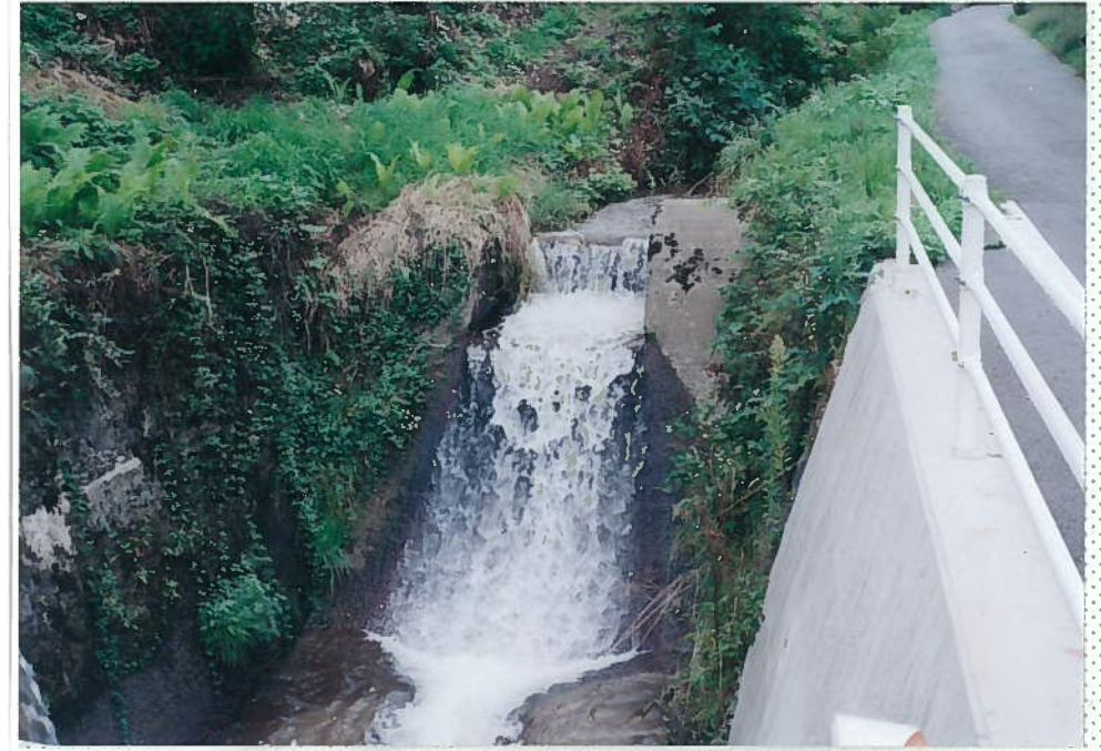
半田川 38. 床固め工。h = 3 m 魚の遡上は不可能である。
