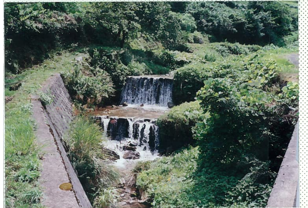
37)福井川 27. h = 1.5\text{m} \times 2 。 段差工があり、魚の 遡上は困難である。
