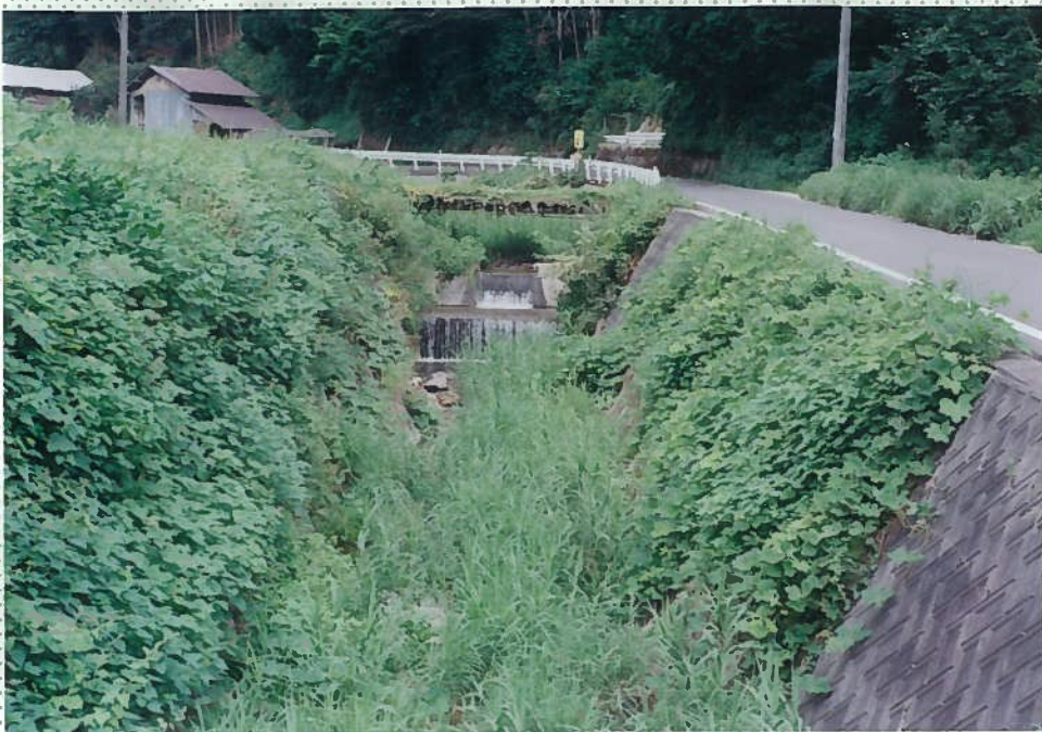
36)羽部川 5. h = 2 m。 護岸を固め、段差工 が連続するため、魚 の影は見られない。
