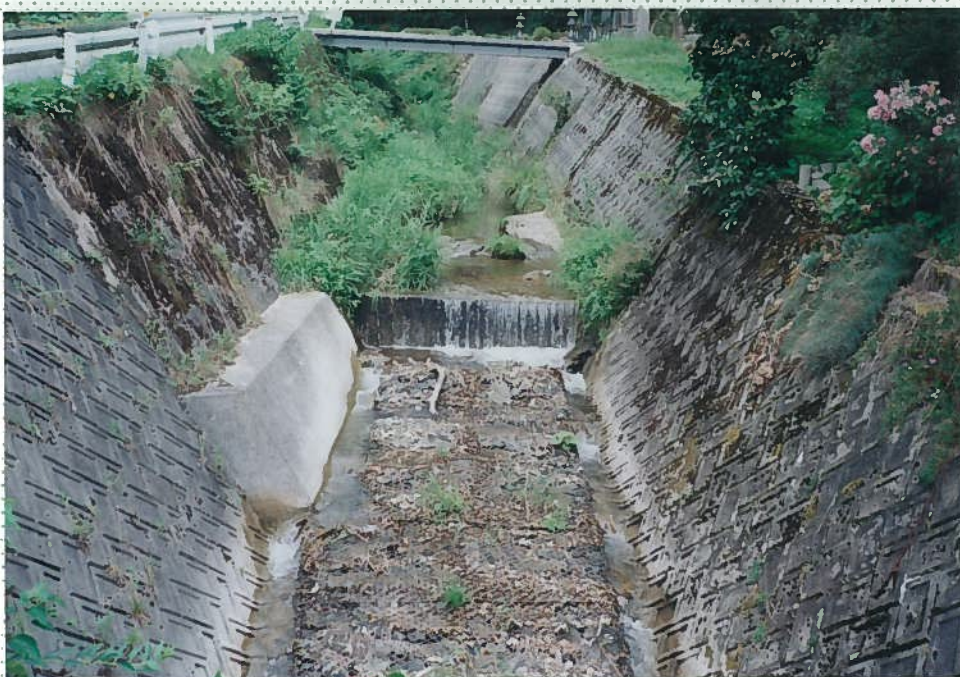
36)羽部川 6. h = 1 m。 蛇籠を付設している が、魚はいない。
