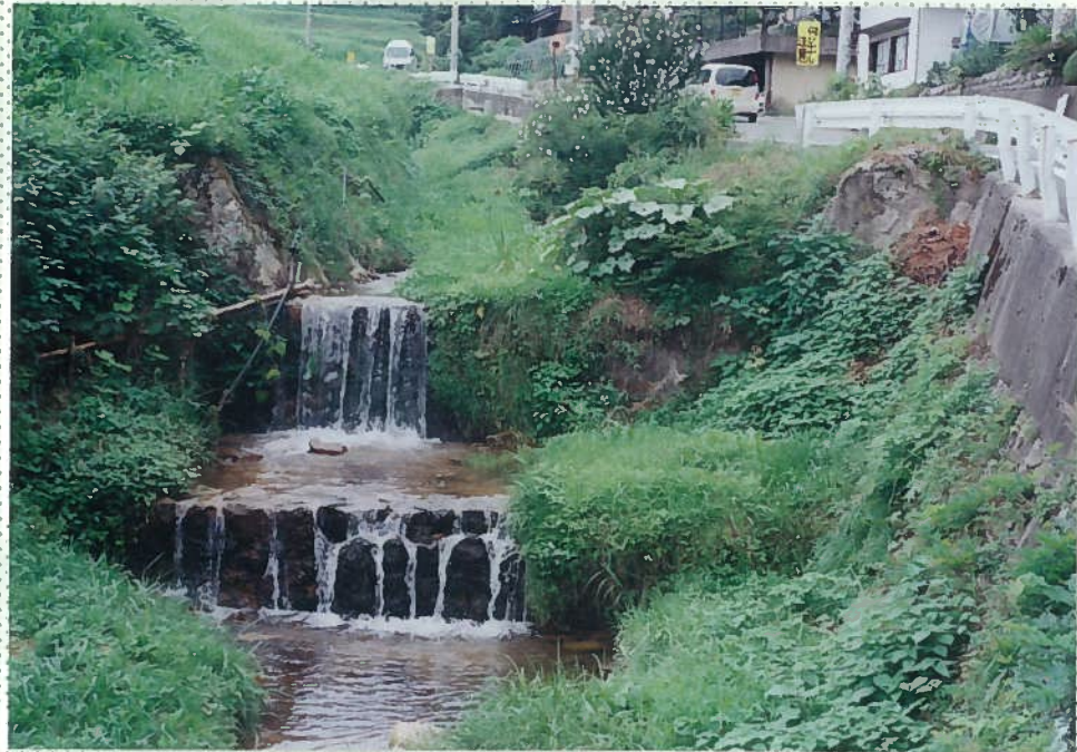
36)羽部川 11. h = 1\text{m} + 1.5\text{m} 。 床固め+段差工が連続する。
