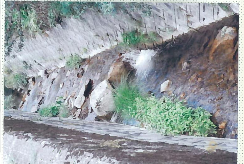
36)小谷 16. 河川状況。 川床は自然の礫が分布する。
