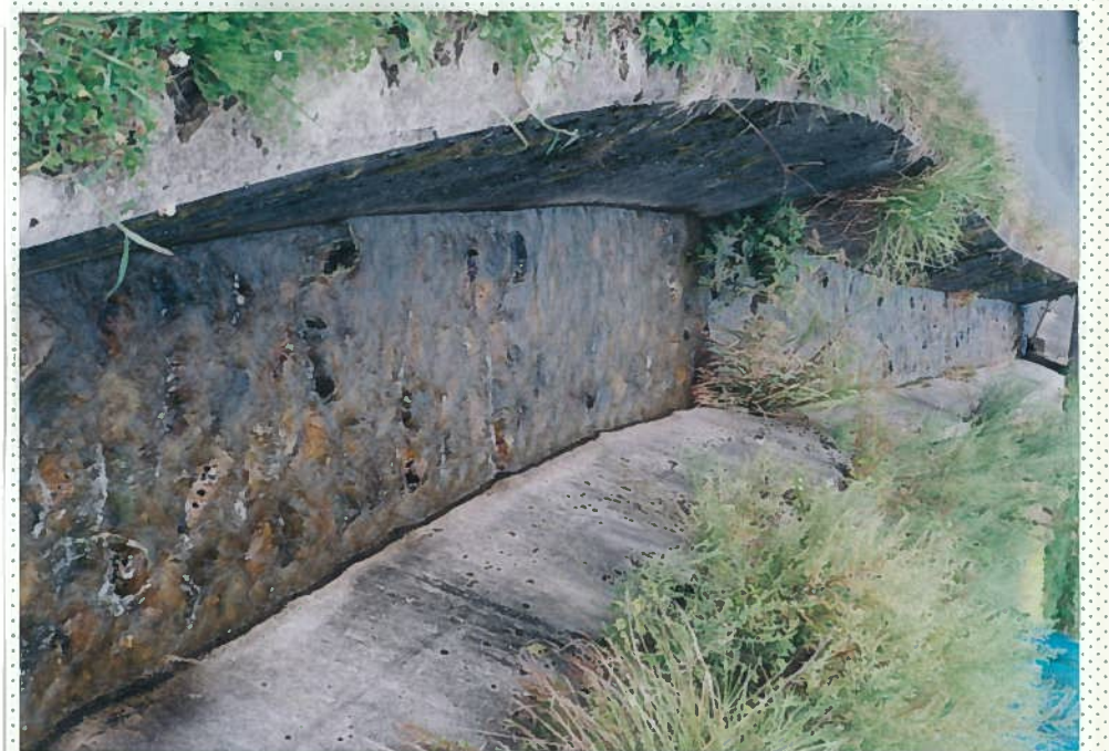
36)小谷 15. 川床は玉石を敷き詰め、三面張となっている。コンクリート張よりは良いが、魚は見られない。
