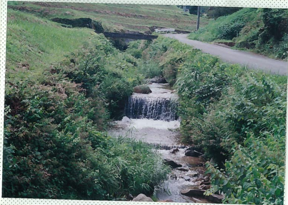
37)福井川 24. h = 1.5\text{m} 。 段差工と床固工。
