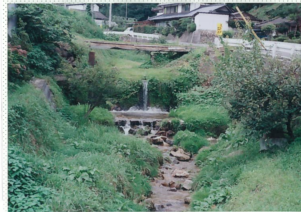
36)羽部川 10. h = 1.5 m。 床固めと段差工が連 続し、魚はいない。
