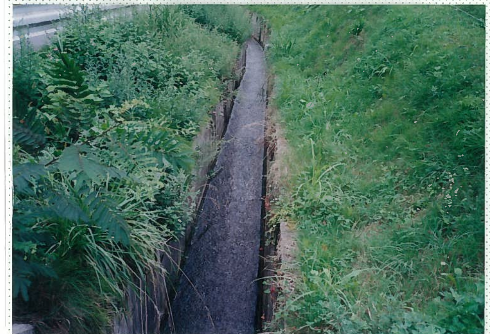
半田川 39. コンクリート水路。 魚は生息不可能である。
