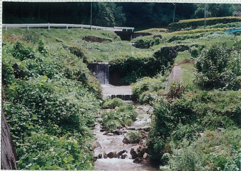
37)福井川 29. h = 1.5m。 魚の遡上は困難。 魚はいない。
