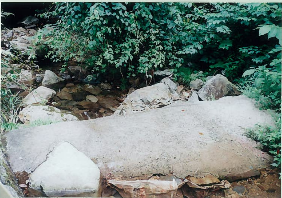
35)鉄山川 29. 頭首工。h = 1 m。 養魚場の取水口である(アメゴ養殖)。
