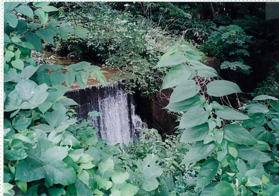
35)鉄山川 31. 砂防ダム。h = 5 m 魚の移動は不可能である。
