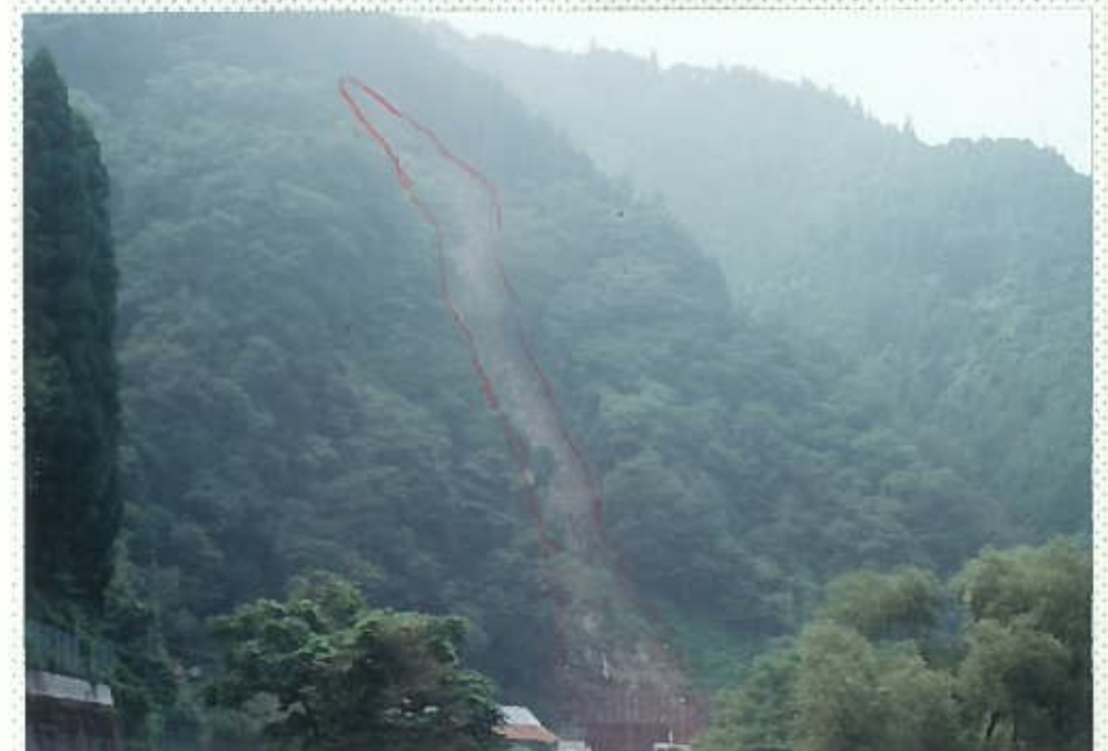
28)旭川 14. 崩壊発生源は植林の 風倒木地。下は急斜 面で雑木林を倒して いる。
