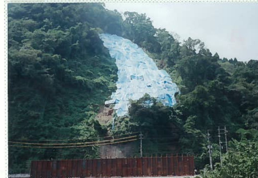
28)旭川 7. 崩壊地。 崩壊跡地が再度崩壊 したように思われる。
