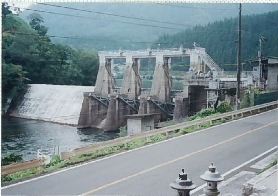
28)旭川 23. 中国電力ダム。 h = 10m。 魚道は無く、魚の移動は不可能である。
