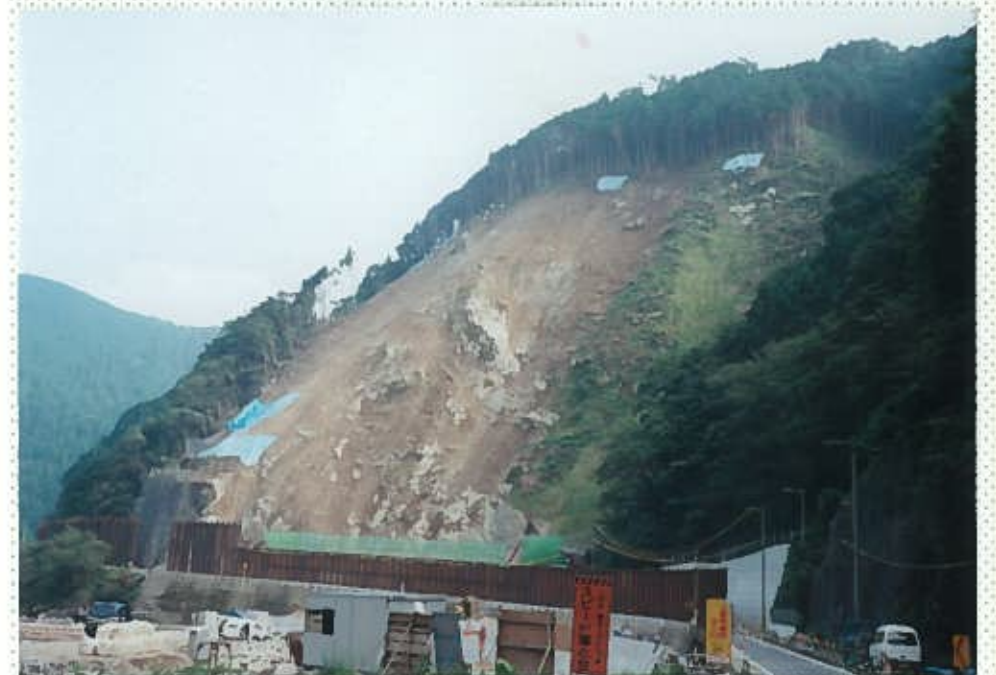
28)旭川 13. 風倒木地の崩壊。 被覆土砂がほとんど 崩落し、基盤岩が露 岩している。 R313号は長期間通行 止めとなった。
