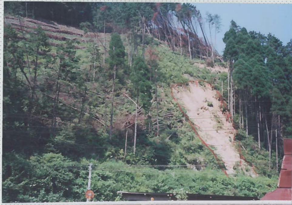
27)三坂川(久世) 8. 風倒木地の斜面崩壊 (7/19の強雨による)。
