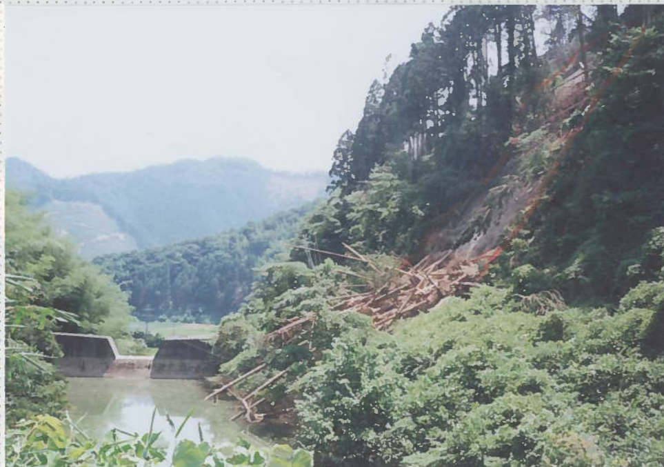
27)三坂川(久世) 24. 同上。 h = 10m。 砂防ダム。
