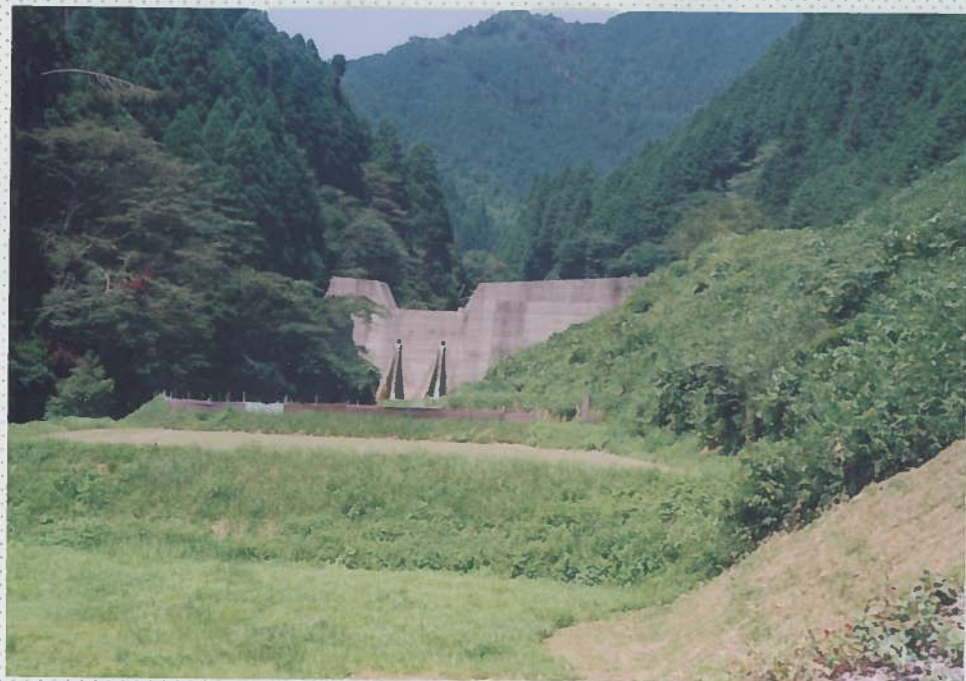
27)三坂川(久世) 18. h = 1.5\text{m} 。 砂防ダムは満砂状態 にある。
