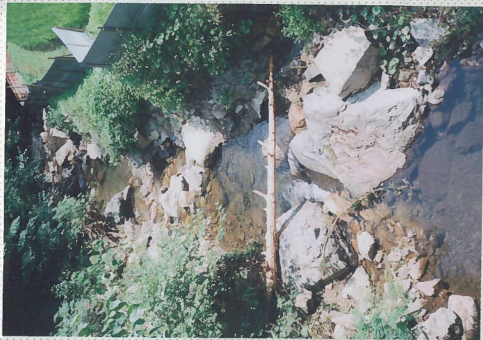
25)山生川 19. 川床状況。 自然状態であるが、 流木・土砂が流れ、 石に泥が付着してい る。
