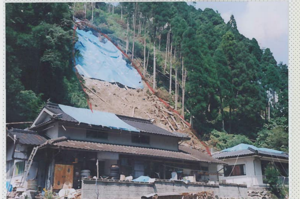
25)山生川 11. 民家と集会所が被災している。
