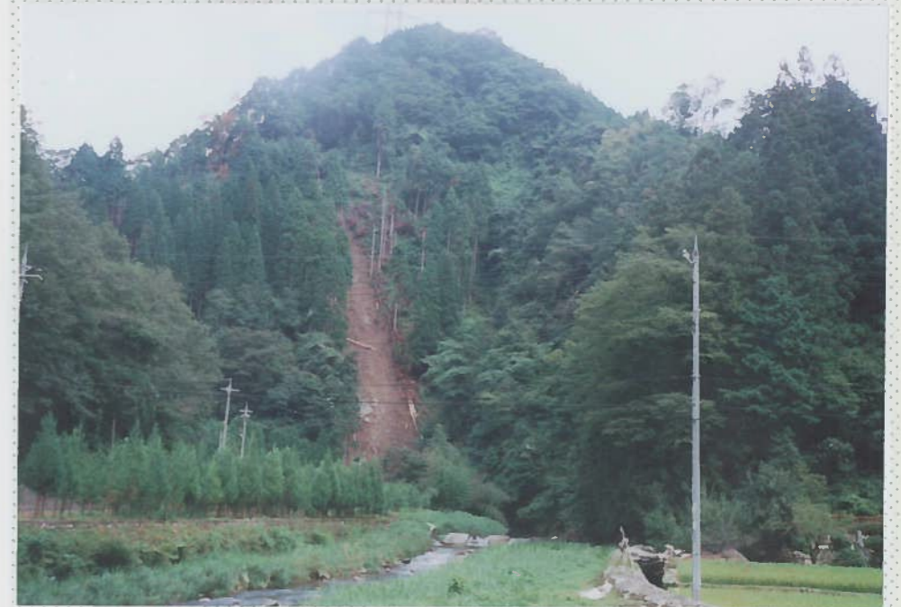
22)余川 17 同上。 崩壊は全て風倒木地 に生じている。
