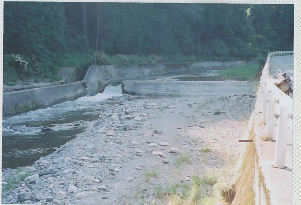
22)余川 6 h=1.5m 土砂の流出が多く石に泥が付着する。7/19災害でアユが減った
