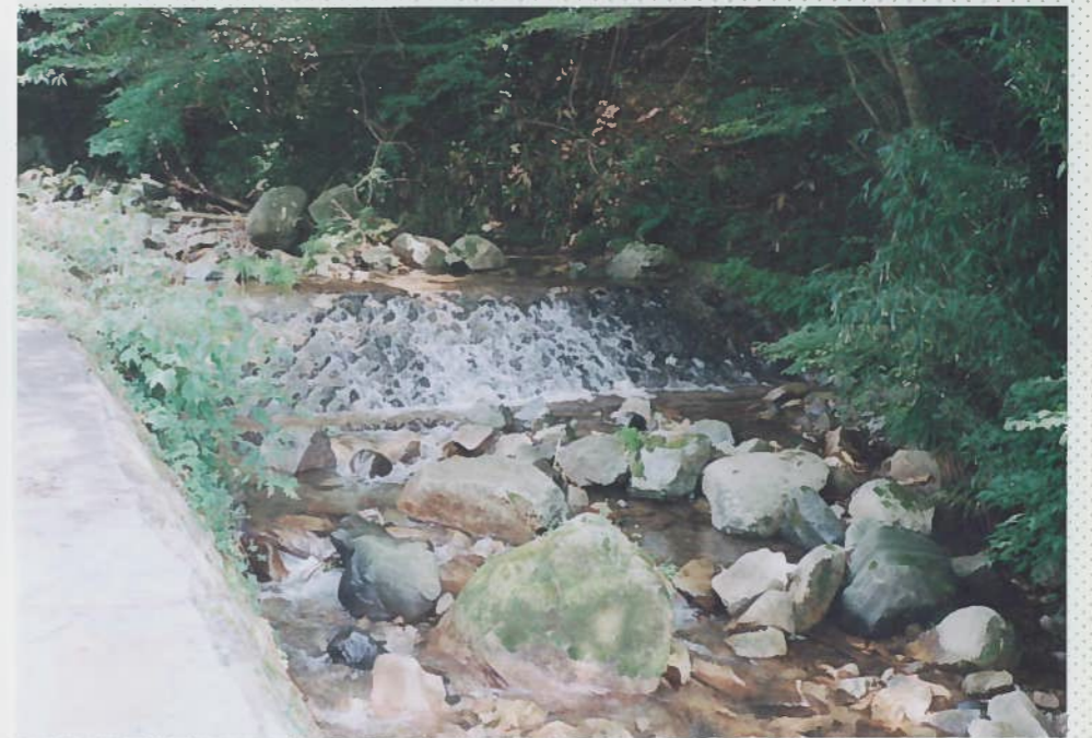
23)立尾川 30 h = 1m。 石積で緩勾配として いる。
