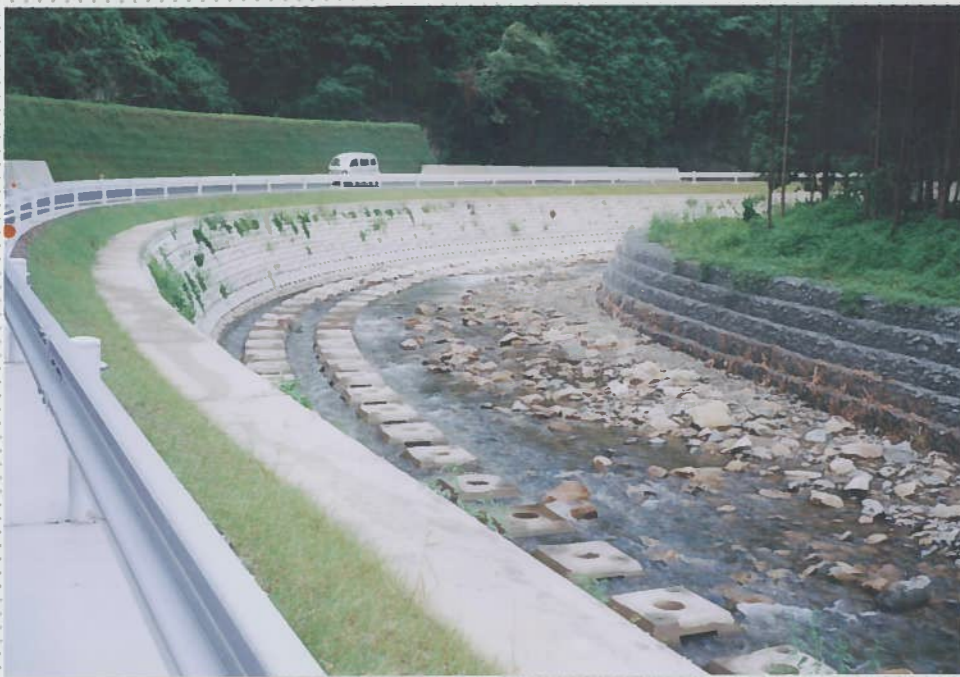
22)余川 13 河川改修で固められ ている。
