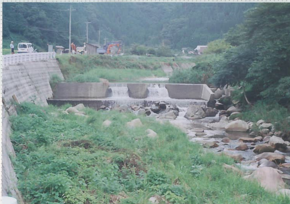
22)余川 21 h = 2 \text{ m} 。 水力タービンを回し て製材ノコを動かし ている。10数年前か ら砂の流出が多くな り、濁り易くなった。 大山椒魚の親子が住 んでいる。
