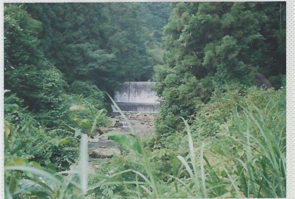
21)白賀川 5. h = 8 m。砂防ダム 白賀川唯一の砂防ダ ムである。これより 下流はハヤ生息。 上流はアメコ放流域。
