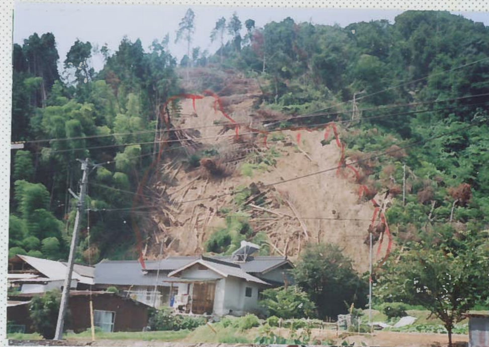
目本川沿い 13. 余野上宇黒地。 表層崩壊は民家に被 災している。
