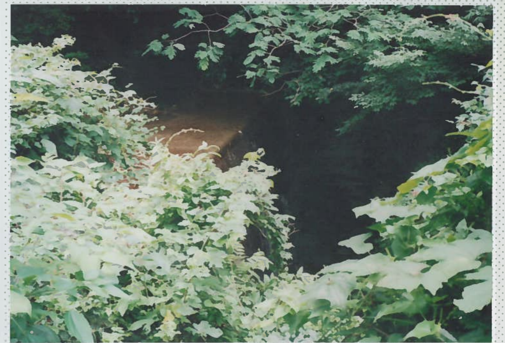
20)目木川上流 25. 正石谷川の砂防ダム。 h = 5 \text{ m} 。 流域は自然保護林で 自然林が広がり、谷 は自然流である。
