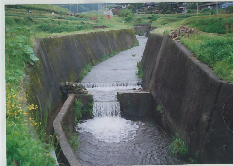
18)当摩川 15 三面張工+段差工 魚の生息は不可能である。
