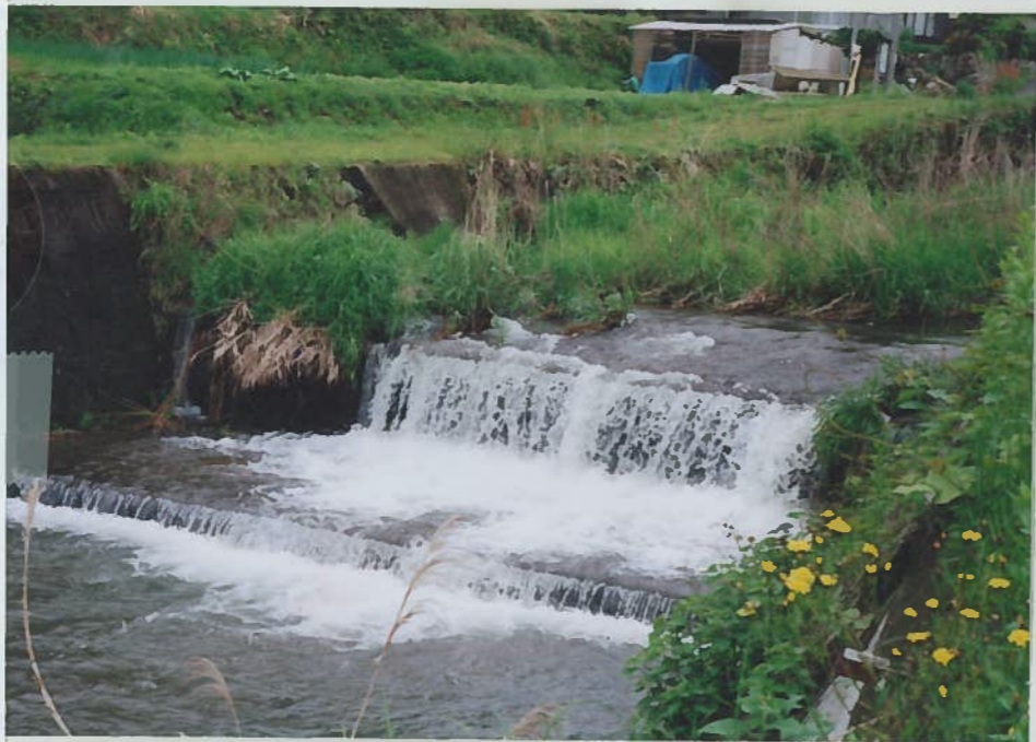
18)当摩川 5 h=1.5m 床固工が広く魚は遡上 しにくい。
