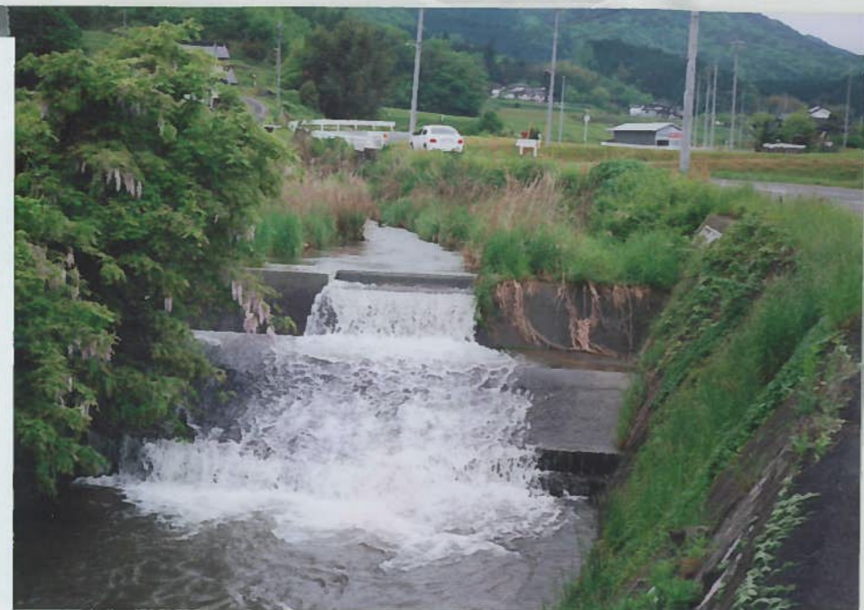
18)当摩川 4 h=2.5m 二段の頭首工で魚は 遡上に苦勞する。
