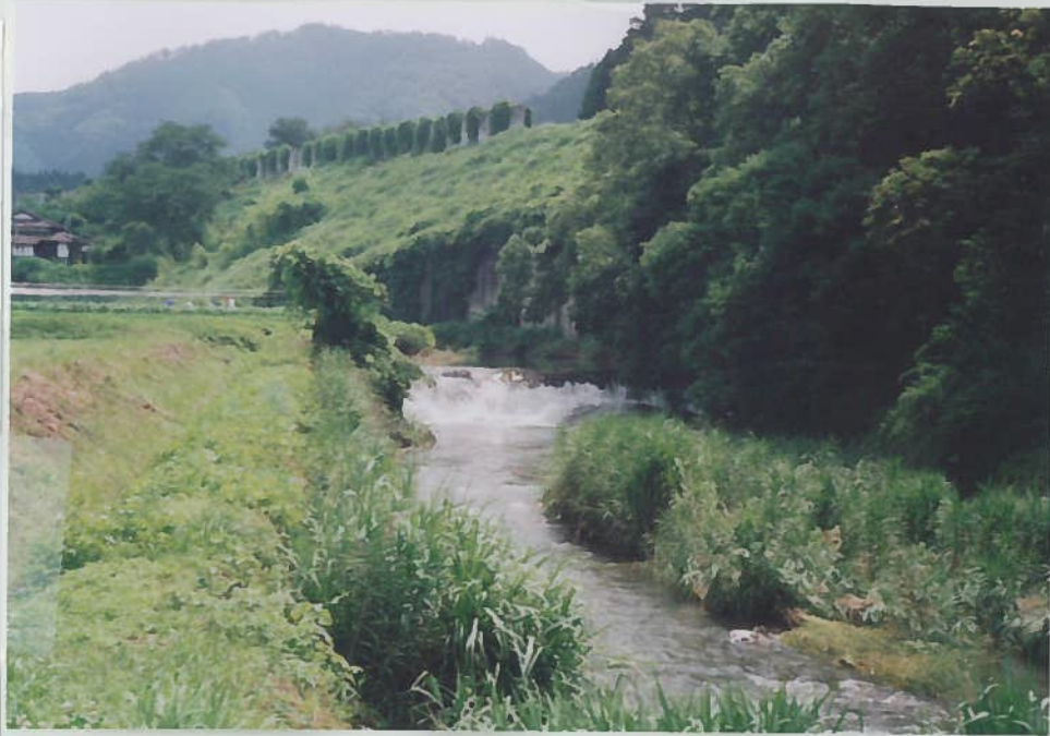
17)河内川 7. h = 3 m。 泥岩が露岩し、滝を形成している。
