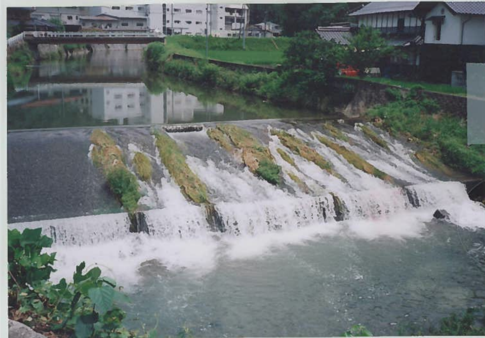
17)河内川 10. h = 3 m。θ = 30°。 緩勾配の頭首工としている。 泥岩が分布するため、その侵食防止が主目的であろう。
