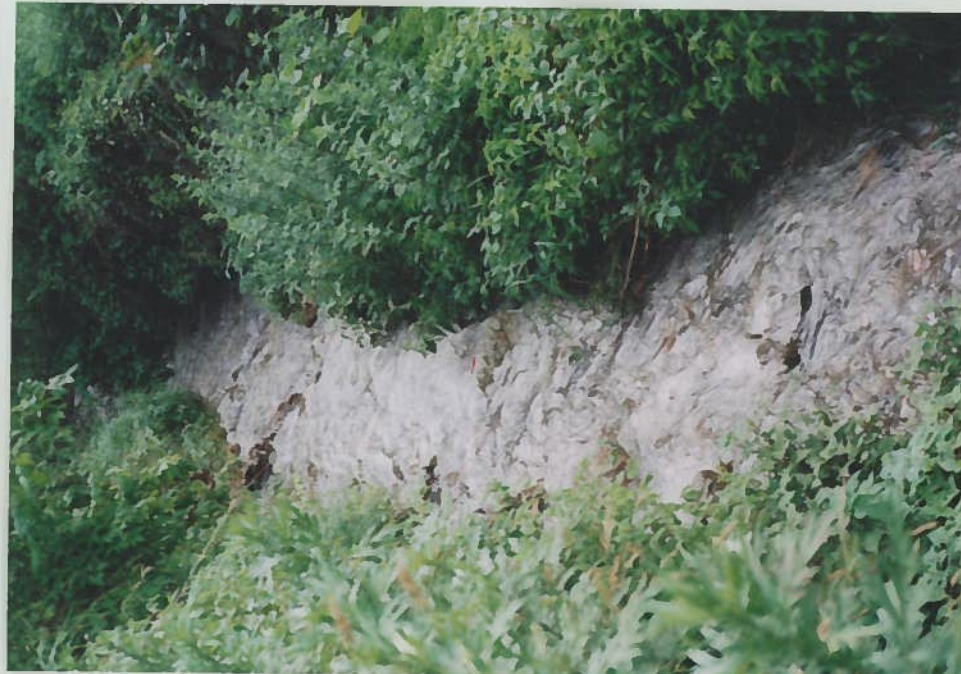
17)河内川(西谷川) 41. 河川状況。 自然河川である。
