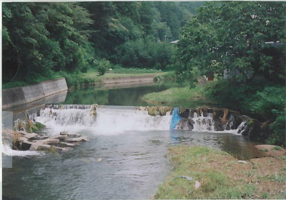
17)河内川 13. h = 1.5m。 石積工で自然に優しい工法である。
