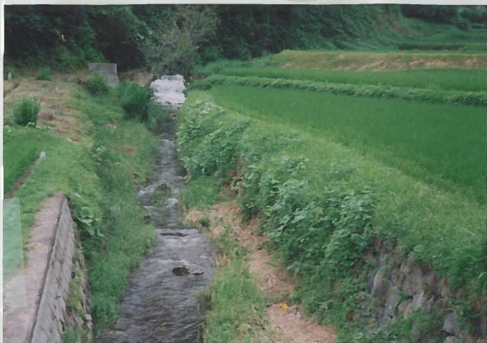
17)河内川(西谷川) 37. h = 2 m。 河川状況。
