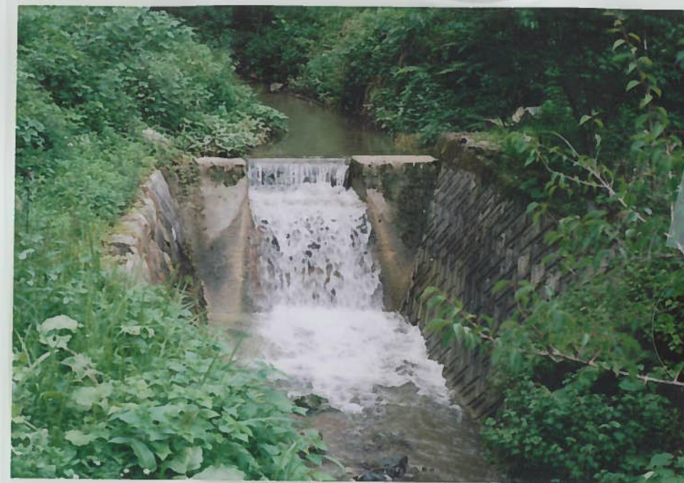
17)河内川(西谷川) 40. h = 2 m。 2~3年前、体長1 mの大山椒魚が上 ろうとしていたが、 幾度も落ちて上が れなかったとのこと。 以前は石積だったが、 台風被害でコンク リート造りとした。 (2010年の台風)
