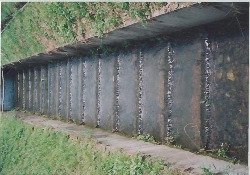
17)河内川 8. 床は侵食防止工でコンクリート板を入れている。
