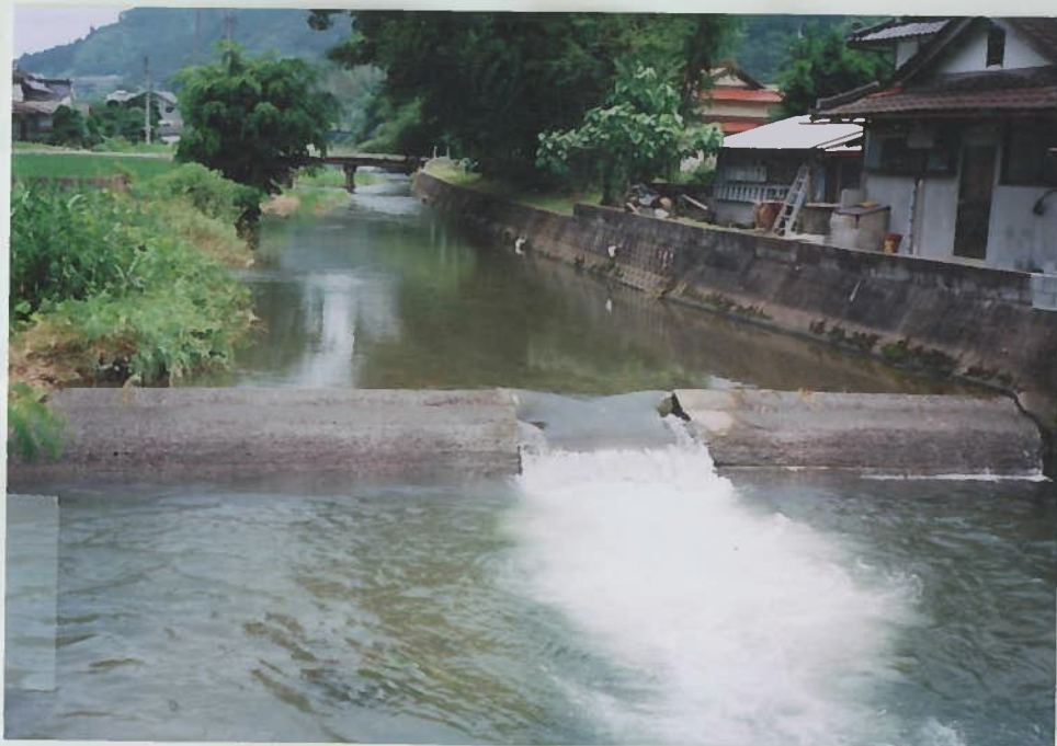
17)河内川 15. h = 1.5m。 河川状況。 淵・瀬があり、魚に優しい川である。
