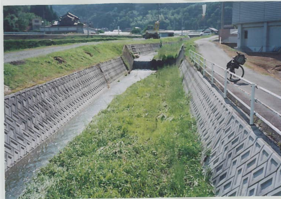
15)中津井川 6 才田支川 三面張工+段差工 魚は全くいない。
