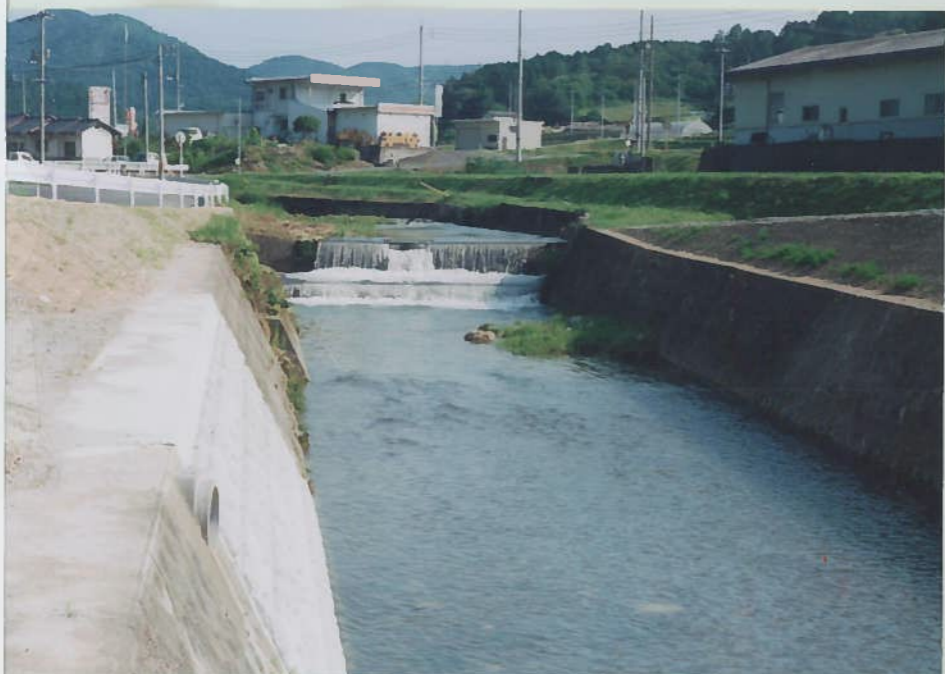
15)中津井川 10 h=2m 床固工があり魚の遡上 は洪水時以外は難しい
