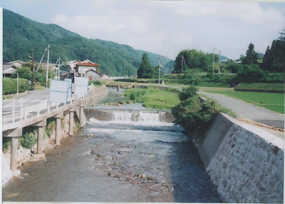
15)中津井川 9 h=1.5m 頭首工+床固工 魚はあまり見られない。
