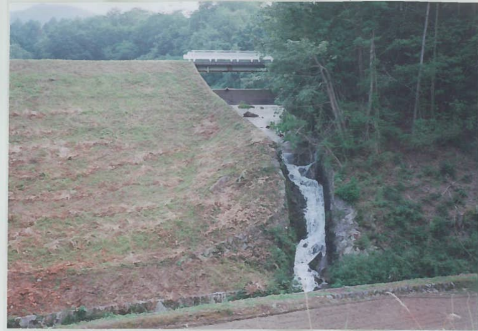
15)中津井川 24 中津井池堰堤
