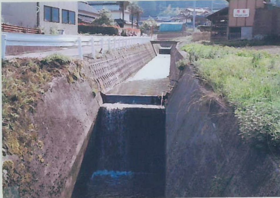
15)中津井川 13 藤田支川 三面張工+段差工 魚はいない。
