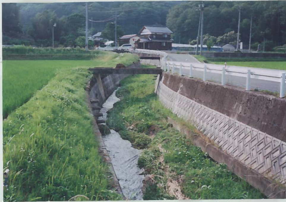
15中津井川 21 支川 三面張工で魚はいない。
