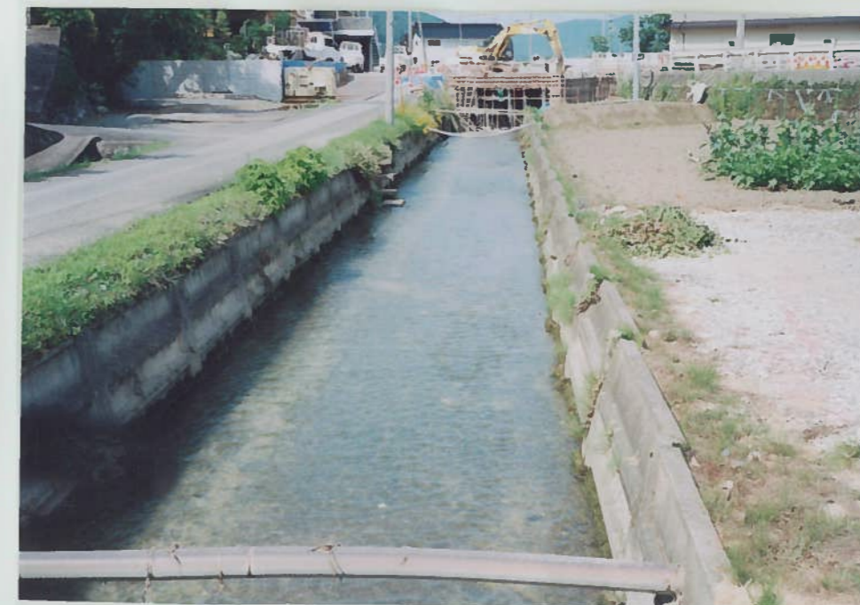
15)中津井川 3 土井支川 三面張工で魚はいない。 水はやや濁っている。
