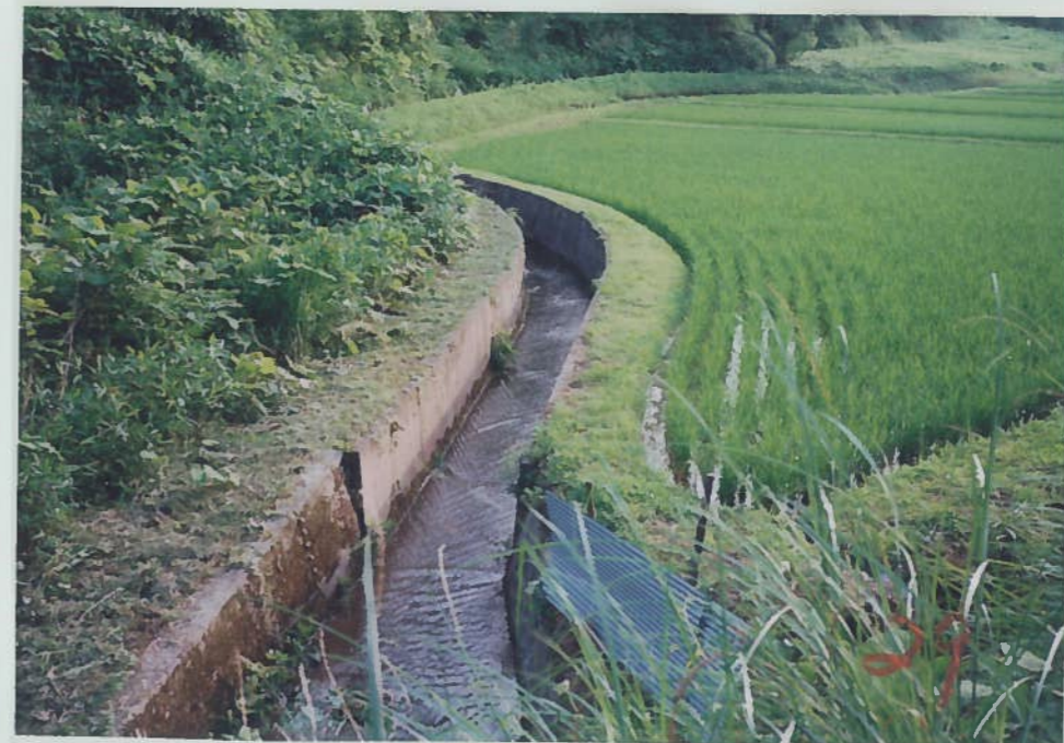
15)中津井川 26 U型溝水路
