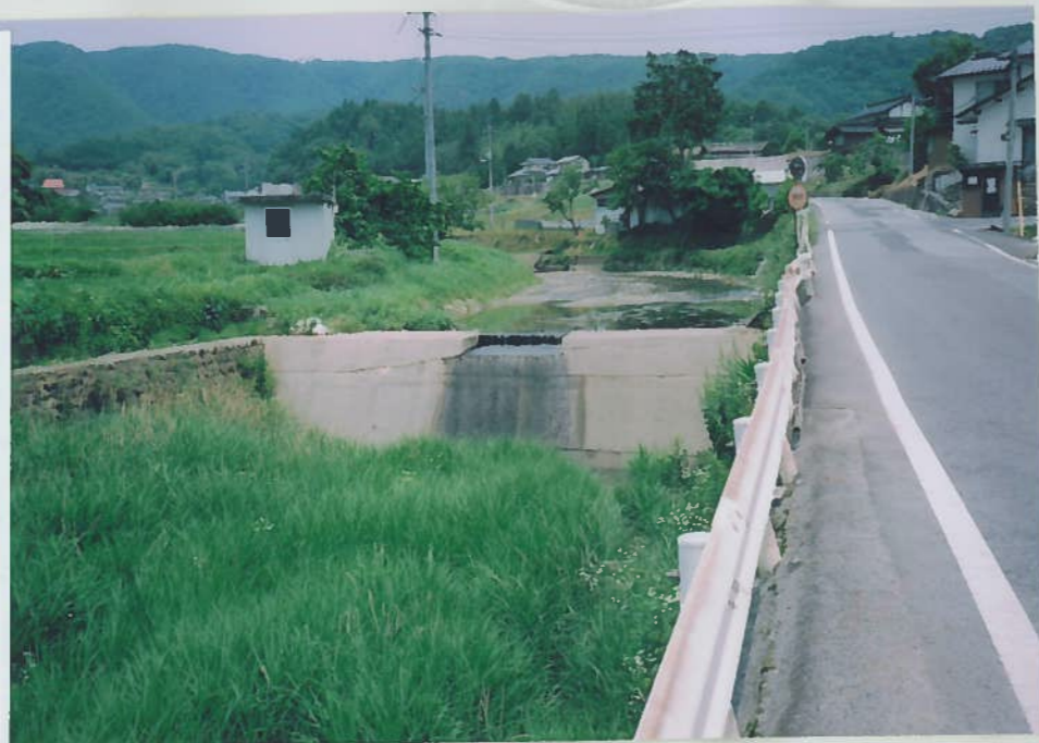
13)興法地川 15 h=2m 魚の遡上は困難 水は少なく砂礫の堆積 する川で魚は少ない。
