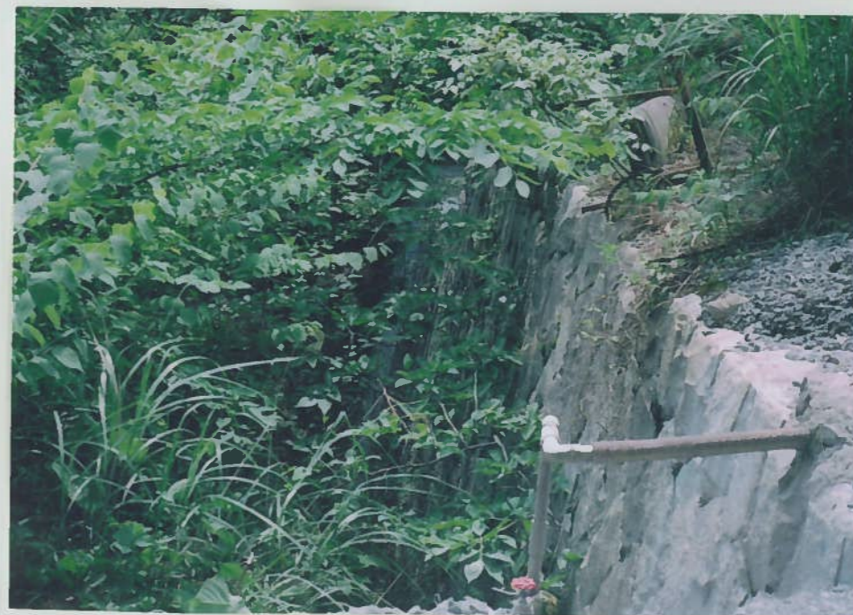
13)興法地川 20 h=8m 砂防ダム 砂礫が堆積し満砂状態 採石場直下に位置する。
