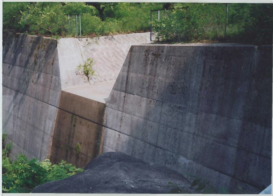
11)宮地川 5 h=10m 土留めダム JHの土捨場を宮地メイ プルパークとして整備
