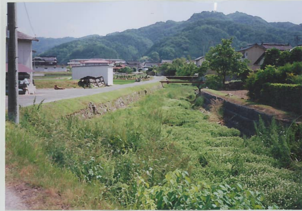
11)宮地川 1 護岸工で流水は少ない。 河床は砂利で水位が低い。
