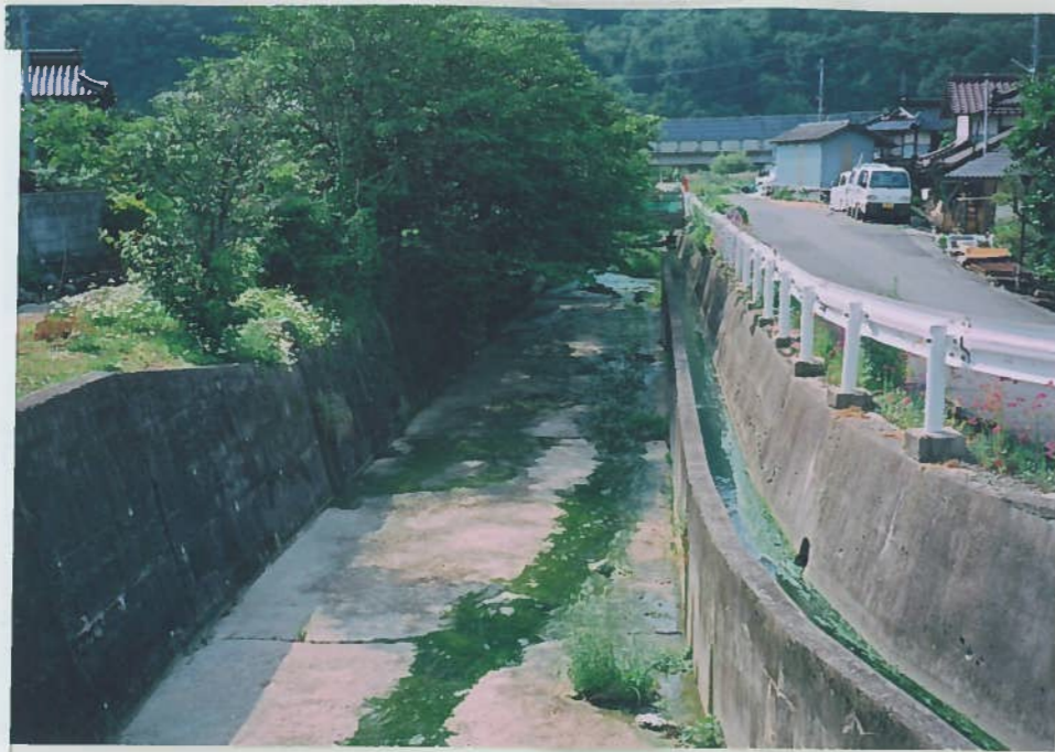
14)飯)谷尻川 21 三面張工で水は無い。
