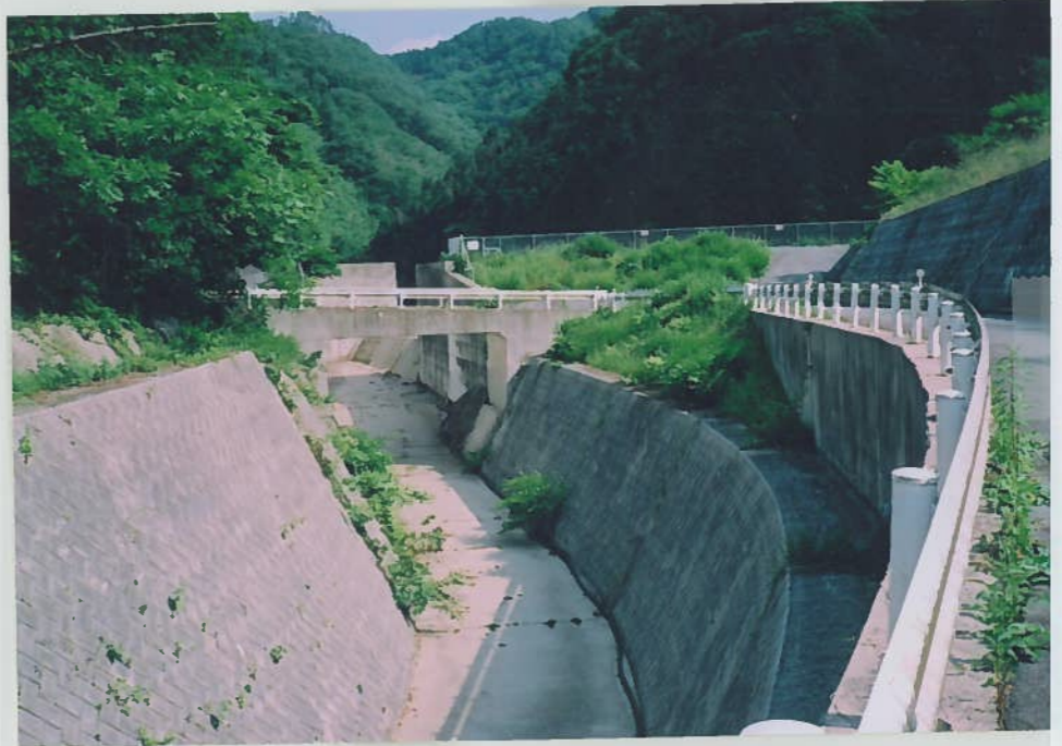
11)宮地川 8 天狗池下 三面張工である。
