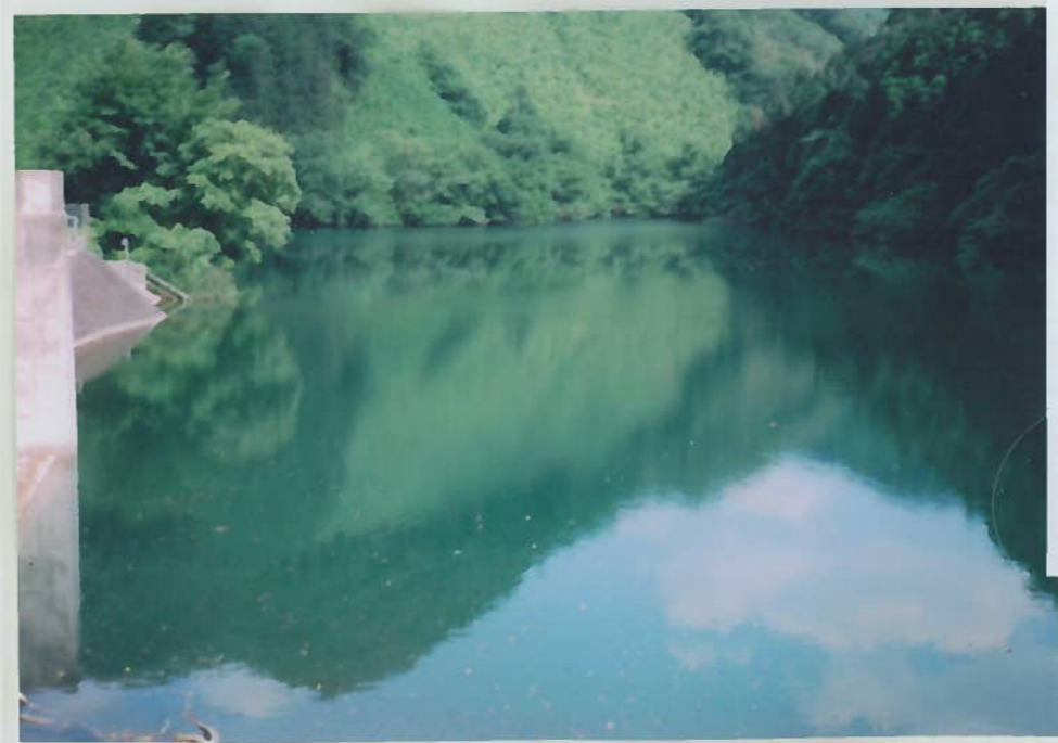
11)宮地川 9 天狗池
