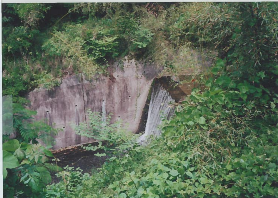
9)関川 10 h=4m 床止堰堤 上流は三面張工である。
