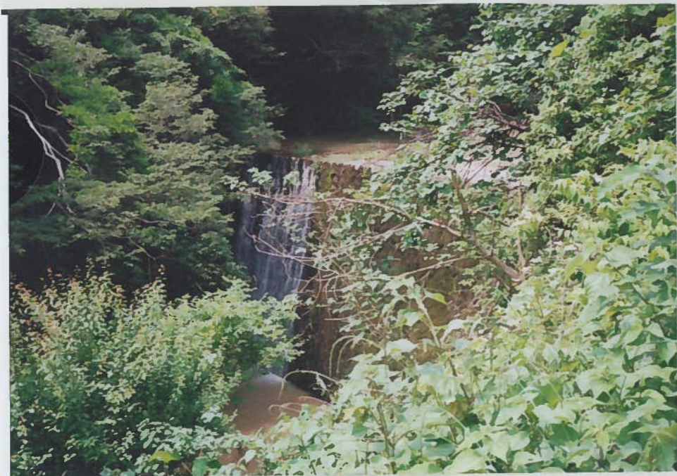
9)関川 9 h=10m 砂防ダム 堆砂により全て埋まっ ている。
