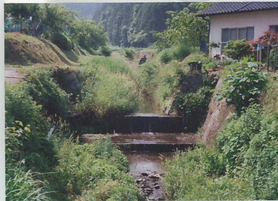
7)竹谷川 1 h=1.5m 頭首工+床固工のため 魚の生息と遡上は難し い。
