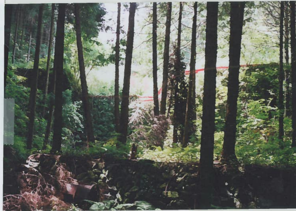
7)竹谷川 5 h=7m 砂防ダム 堆砂で満砂となり上流 側に流水なし
