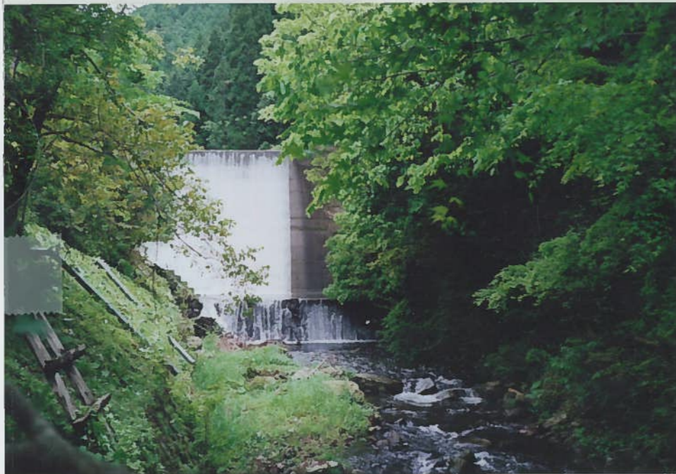
5)西河内川 11 h=8m h=15m 西河内川砂防ダム S54. 3岡山県
