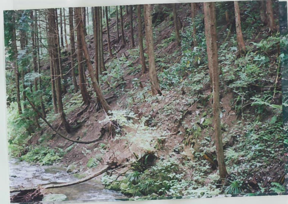
5)西河内川 13 植林地 草木が無く土砂が川へ 流れ込んでいる。
