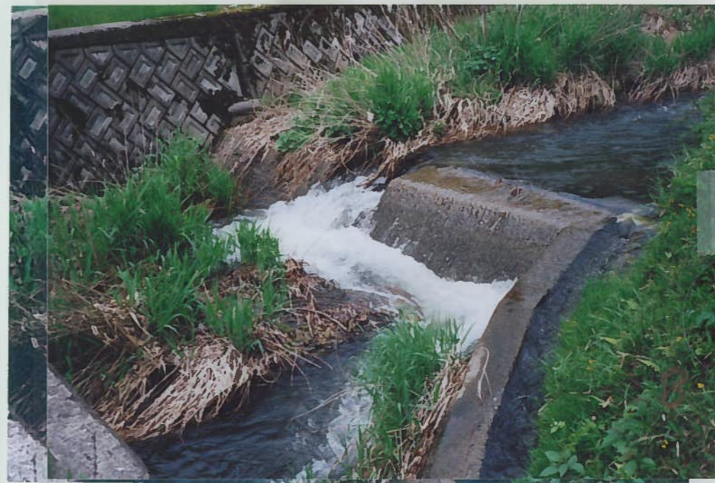
5)西河内川 8 h=1m 川床にフトン籠を敷き 水草を生やしている。
