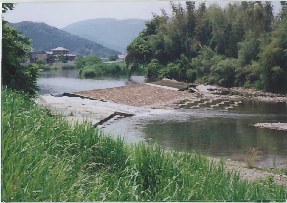
1)備中川 4 階段工があり魚の遡上は楽である。 水は淀み、濁りと泡があり、水質はやや悪い。
