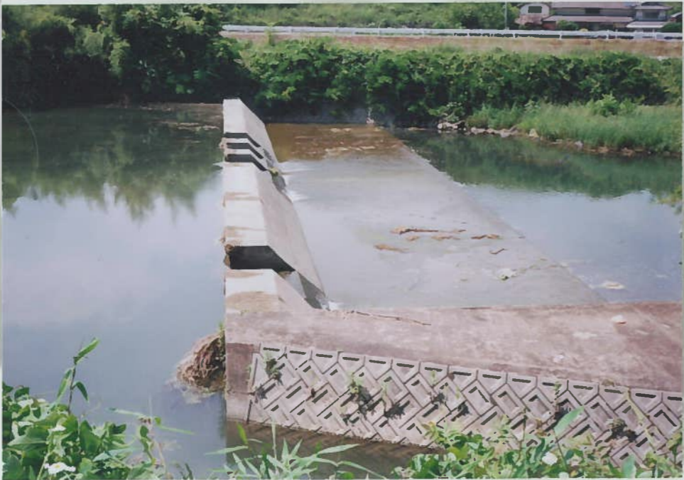
2)備中川 6 同上頭首工 床固工があり魚の遡上しがたい構造である。
