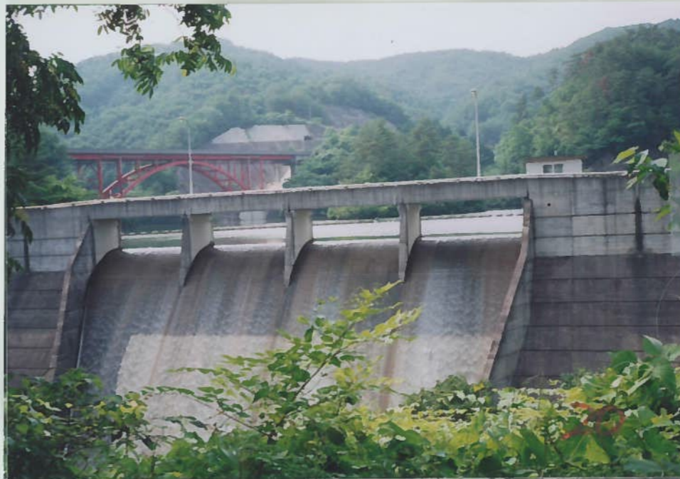
3)備中川 38 北房ダム h=35mの重力式ダム。
