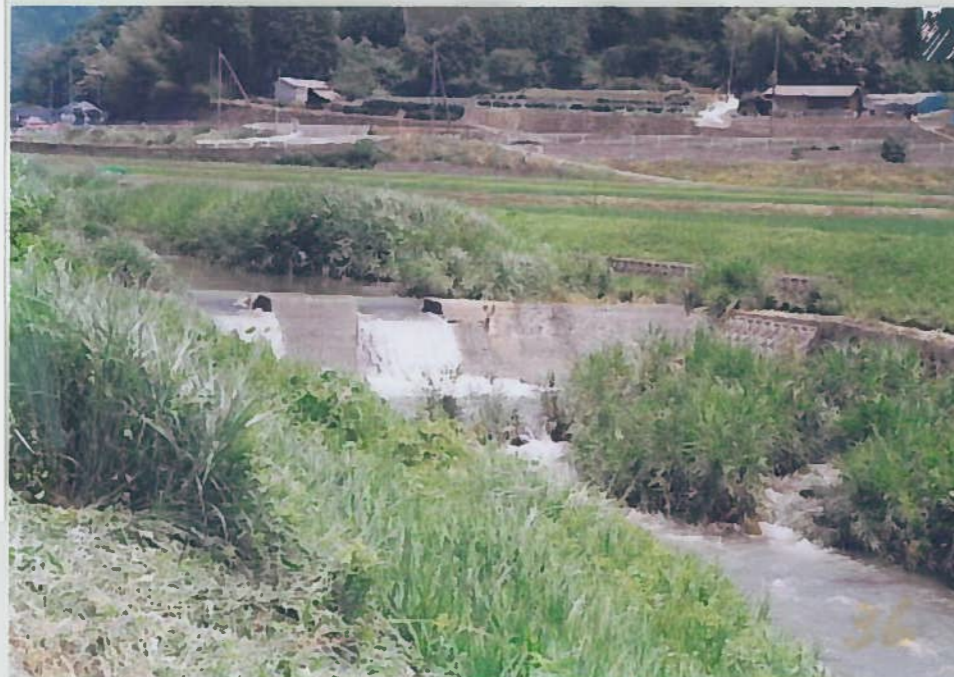
3)備中川 18 h=2m 床がため工はあるが 魚は遡上可能である。
