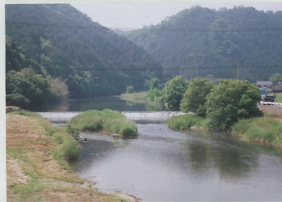
1)備中川 3 頭首工 h=1.5m 魚の遡上可能である。
