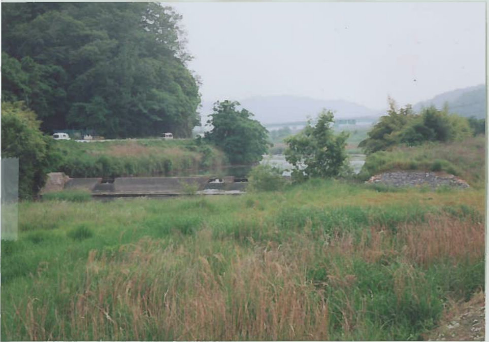
2)備中川 5 湯川大出 h=1.5m 頭首工上は淀み、水質はやや悪い。
