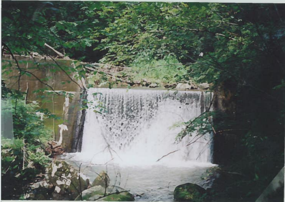
4) 弥谷川 29 h=5m 砂防ダム ダムが2基存在し、魚の移動は不可能である。
