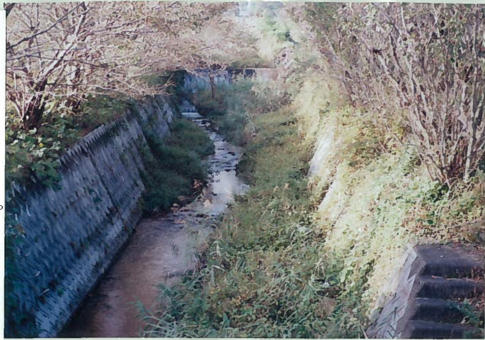
52)戸谷川 27. 床止工 h = 2.5 m 魚の遡上は不可能で ある。また魚もいない。
