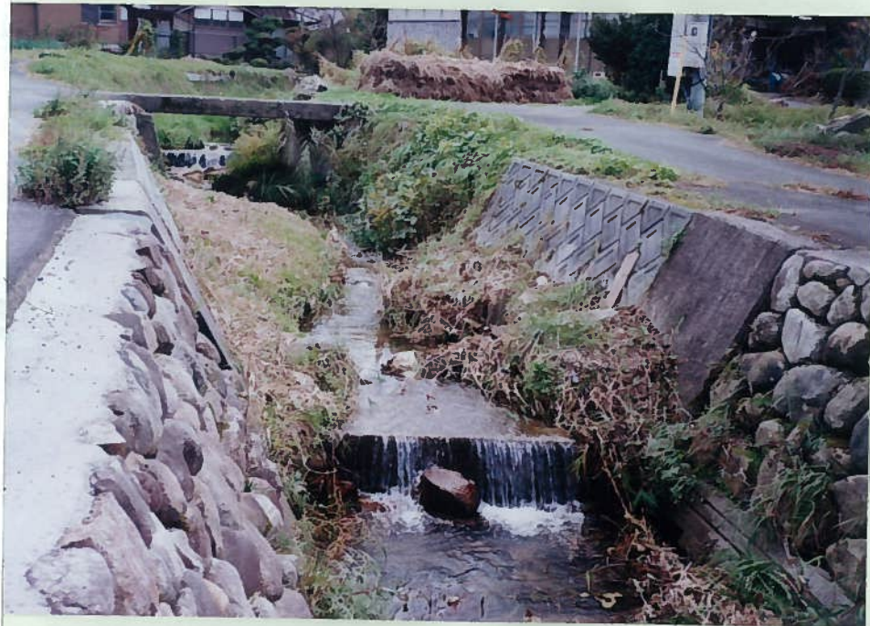
栃ノ木支川 11. 護岸工で固め床止工 が入る。
