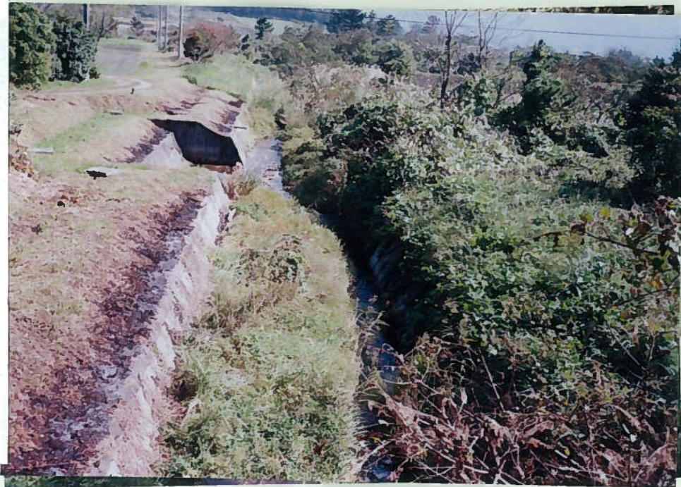
52)宮城川 35. 河川状況 護岸工で固められ、 細い流れをなす。 魚はほとんどいない。
