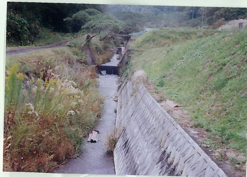
51)山城川 9. 三面張と床止め工が 連続する。 h = 1 ~ 1.5 m 魚は生息できない。
