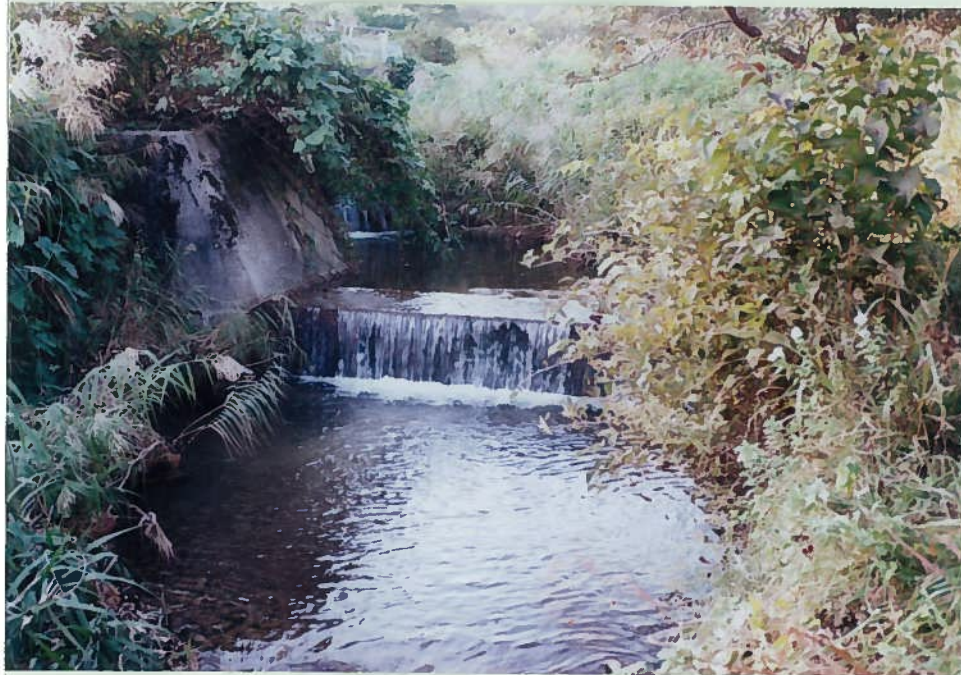
52)戸谷川 28. 床止工 h = 1 m × 2段 上流に牛舎、放牧地 があり、以前は汚水 がひどく鯉も死んだ 昔はウナギ・山椒魚 も多数いたが、今は アブラハヤもなにも いない、とのこと
