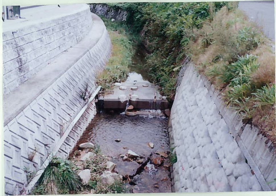
栃ノ木支川 13. 護岸を固め、床止工 が入る。魚はほとん ど見られない。
