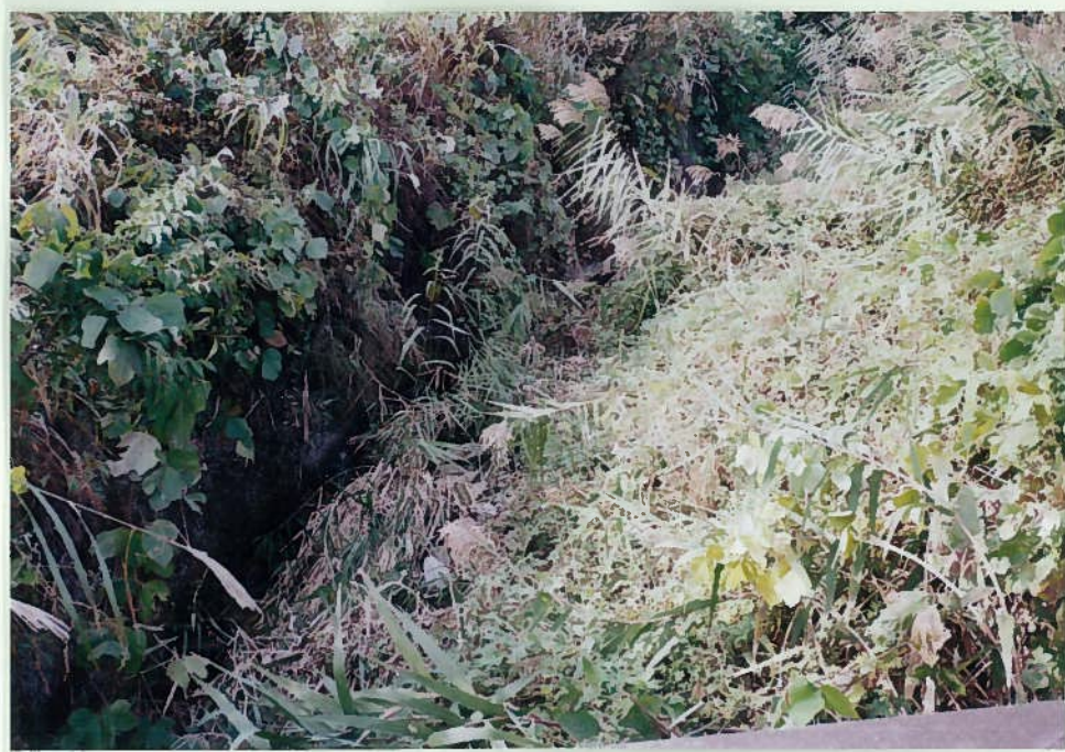
53)仮)道目木川 38. 護岸工+植生 草が茂り、水の流れ は細く、魚は見られ ない。 今は魚も大山椒魚も いないとのこと。 農薬・尿尿が降雨時 に流入する。
