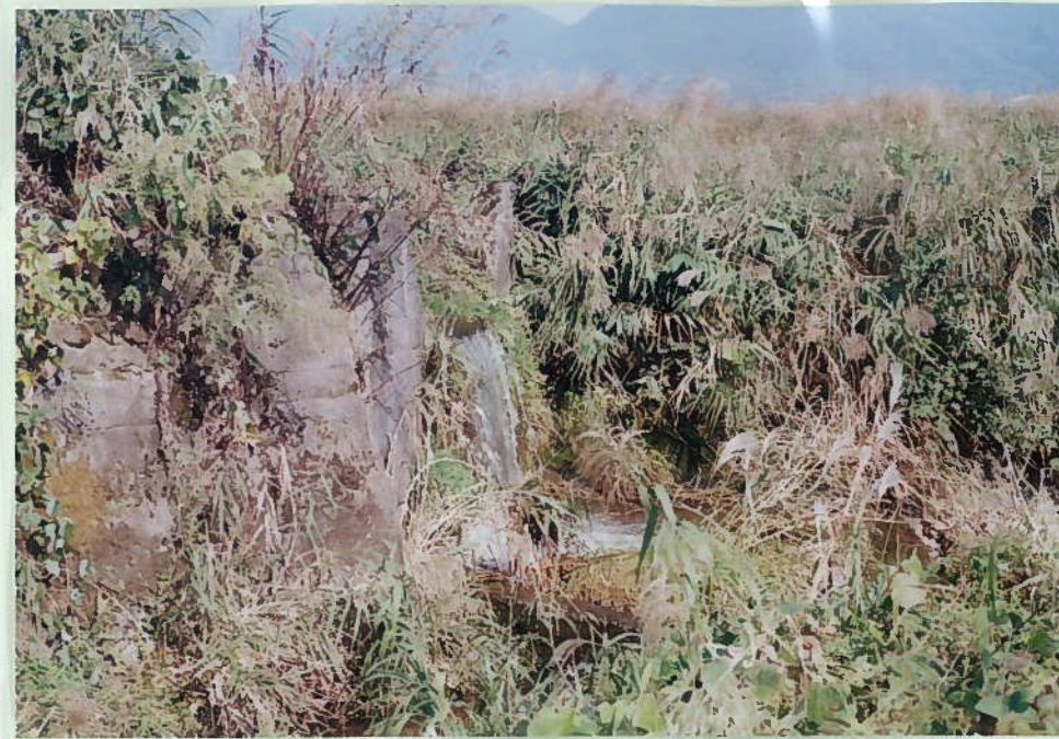
53)仮)道目木川 36. 床止ダム h = 1.5 m 魚の遡上は不可能。 下に魚は止まっている。
