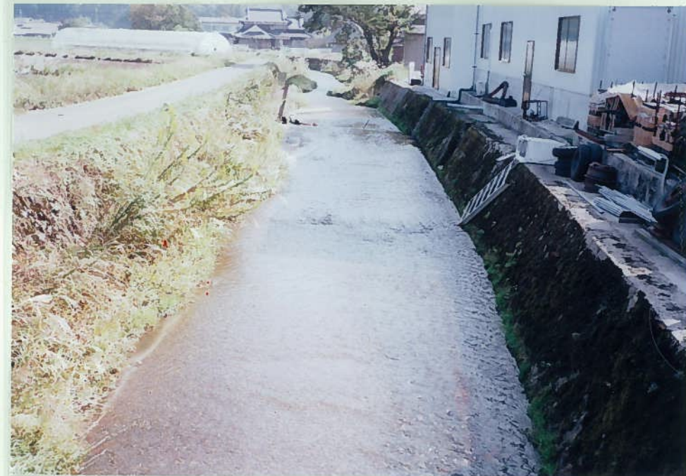
52)宮城川 31. 三面張工 魚は住めない。
