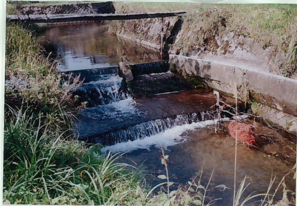
52)宮城川 30. 頭首工 h = 1.5 m この下にハヤが多数 留まっている。
