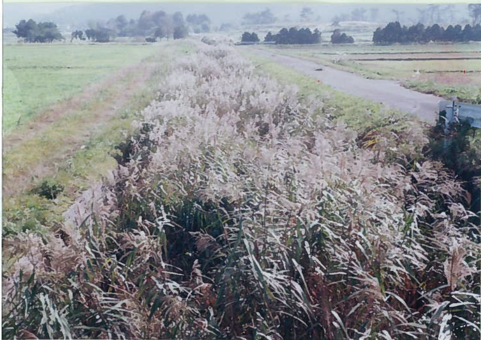
52)高松川 22. 直線的な護岸でヨシ が茂るが魚の姿は見 えない。
