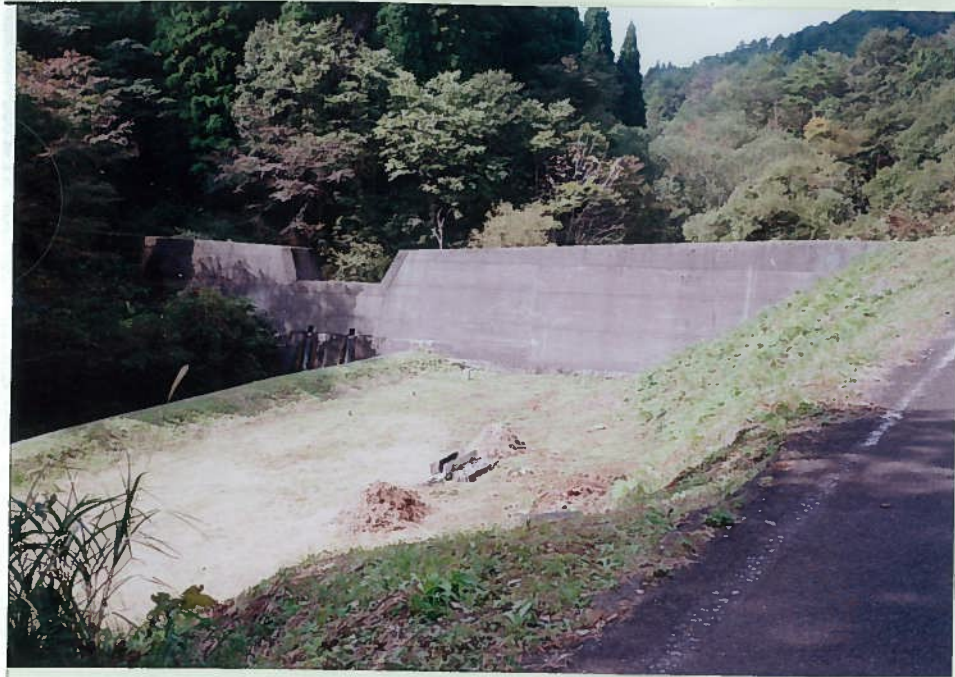
51)山城川 10. 砂防ダム h = 8 m 辻料理専門学校前 これより上流は溜沢 である。
